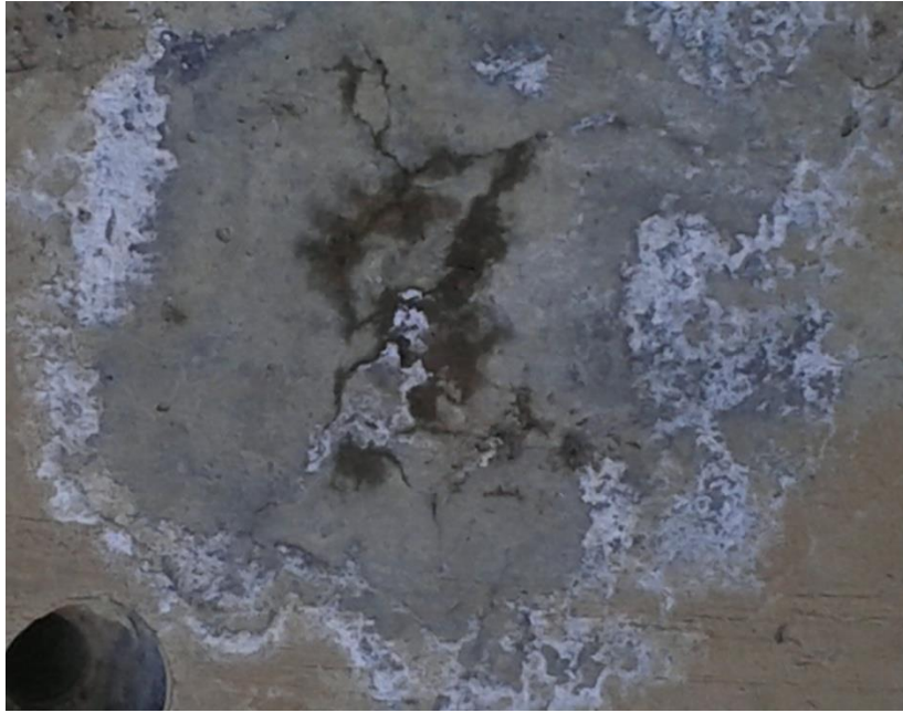
FOTOGRAFÍA III-18 REPRESA SAN JACINTO-PARTE IZQUIERDA DEL CUERPO DE LA PRESA FUENTE: Elaboración propia
