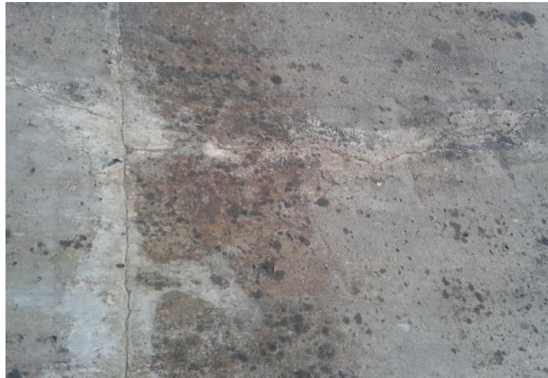
FOTOGRAFÍA III-19 COLORACIONES Y FLUORESCENCIAS-PRESA SAN JACINTO FUENTE: Elaboración propia
