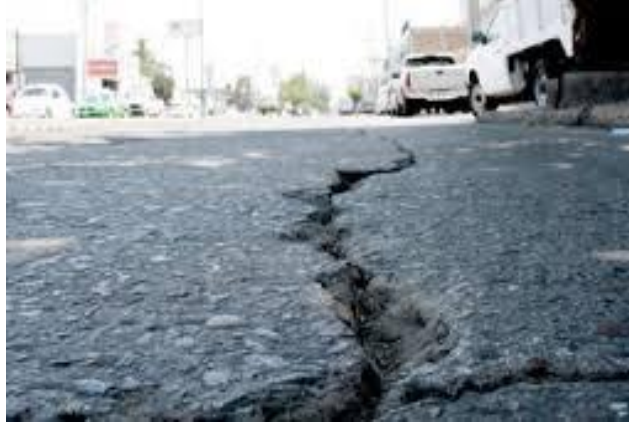
Fotografías 2.14. Segregación longitudinal en pavimento asfáltico. Capítulo 3 “Mezclas Asfálticas”, Alejandro Padilla Rodríguez.
