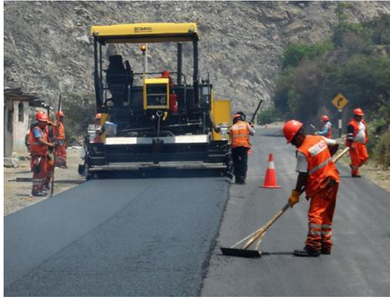
Figura 2.11 Mezcla en sitio. Fuente: http://civilgeeks.com/2014/04/29/como-evitar-contaminacion-de-mezclas-asfalticas-recomendaciones-del-inveas/
