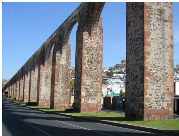
Figura 2.15 Acueducto de Querétaro.
