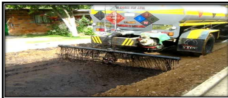
FIGURA 2.24 Estabilización con asfalto
