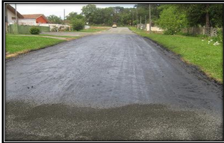
FIGURA 2.23 Estabilización de Suelos
