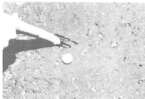
Figura B-2.b. Exudación o Sangrado Media-severidad.
