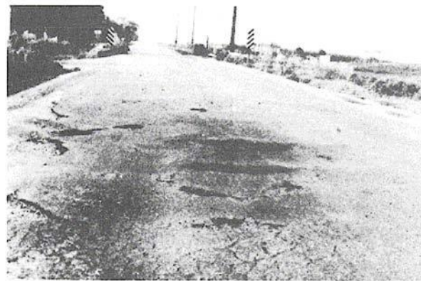
Figura B-16.b. Empellones Media-severidad.
