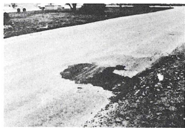
Figura B-11.b. Parchados Media-severidad.
