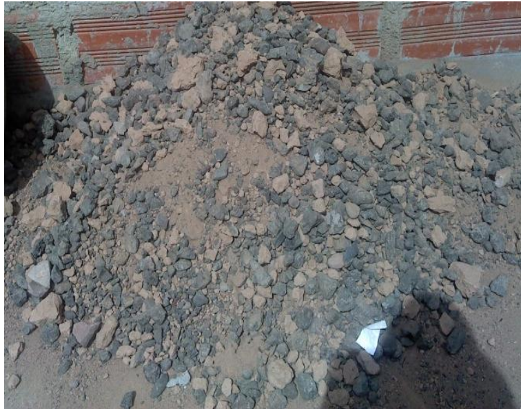
Material acopio para capa base
