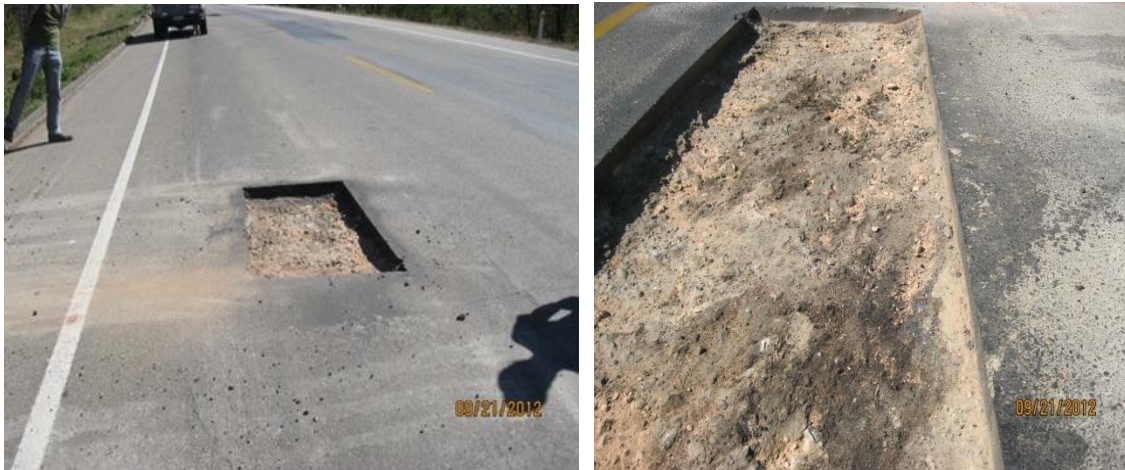
Reciclado de capa de rodadura
