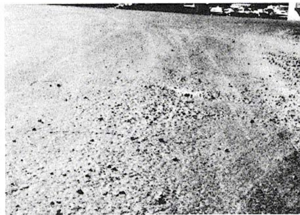
Figura B-19.b. Intemperismo Media-severidad.
