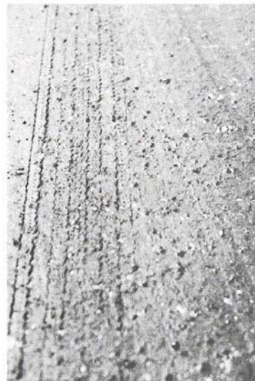
Figura B-2.c. Exudación o Sangrado Alta-severidad.
