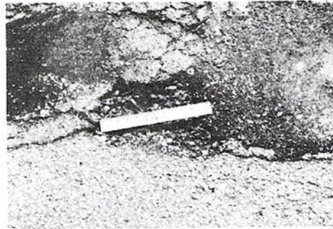
Figura B-13.a. Baches Baja-severidad.
