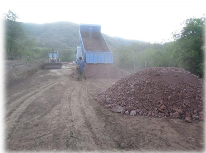
FIGURA N° 6 Esparcido del material para el ripiado
