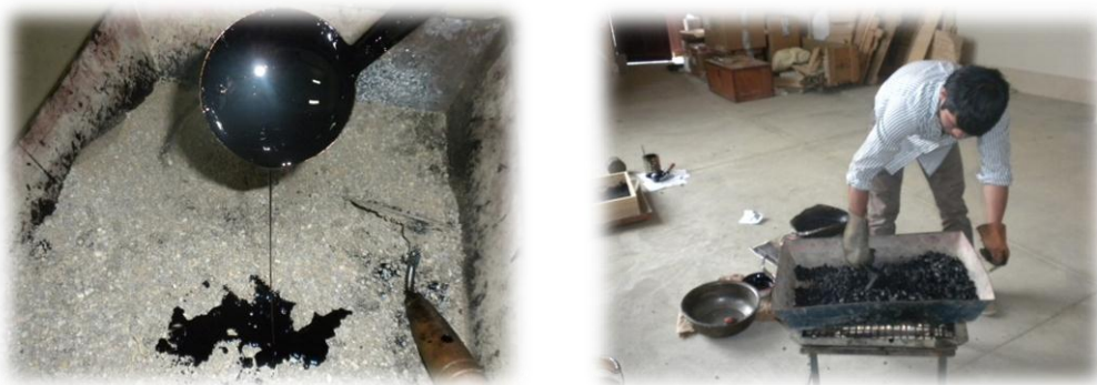
FIGURA N° 66 Dosificación de tratamiento superficial e imprimación reforzada en el laboratorio
