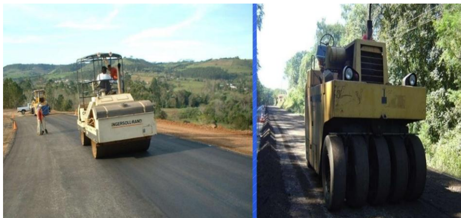
FIGURA N° 4 Compactado (Crespo Villalaz, 1996)
