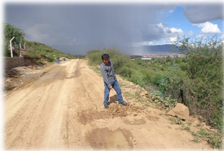
FIGURA N° 17 Camino de tierra de la comunidad de Obrajes
