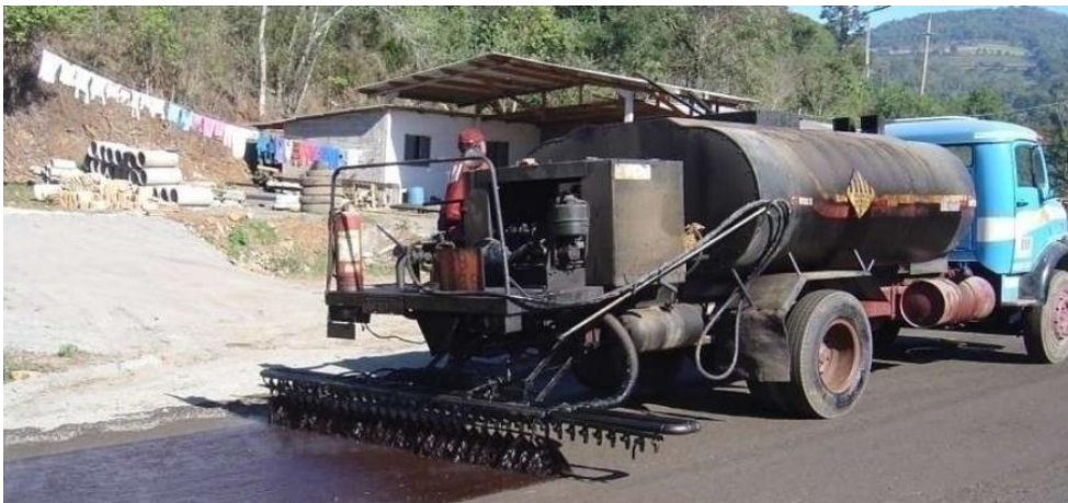
FIGURA N° 2 Esparcido del asfalto (Crespo Villalaz ,1996)
