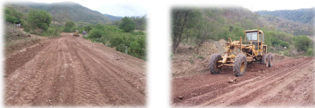
FIGURA N° 55 Esparcido del material para el ripiado
