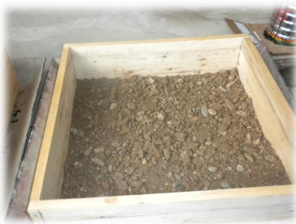
FIGURA N° 61 Escarificación de la base
