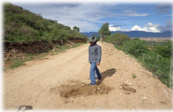
FIGURA N° 13 Camino de tierra de la comunidad de Obrajes
