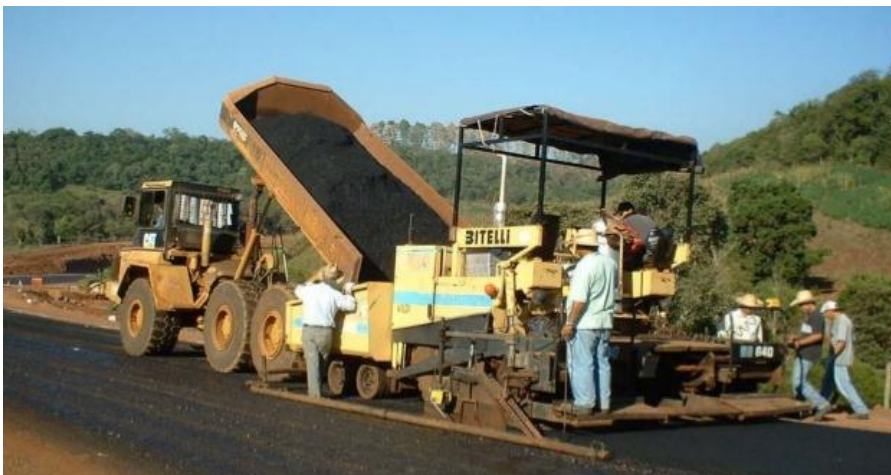
FIGURA N° 3 Distribución del agregado (Crespo Villalaz, 1996)
