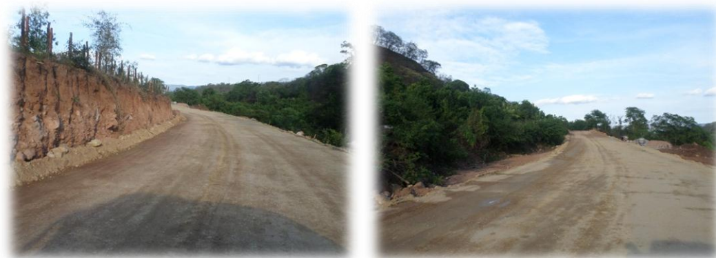
FIGURA N° 57 Camino ripiado acabado
