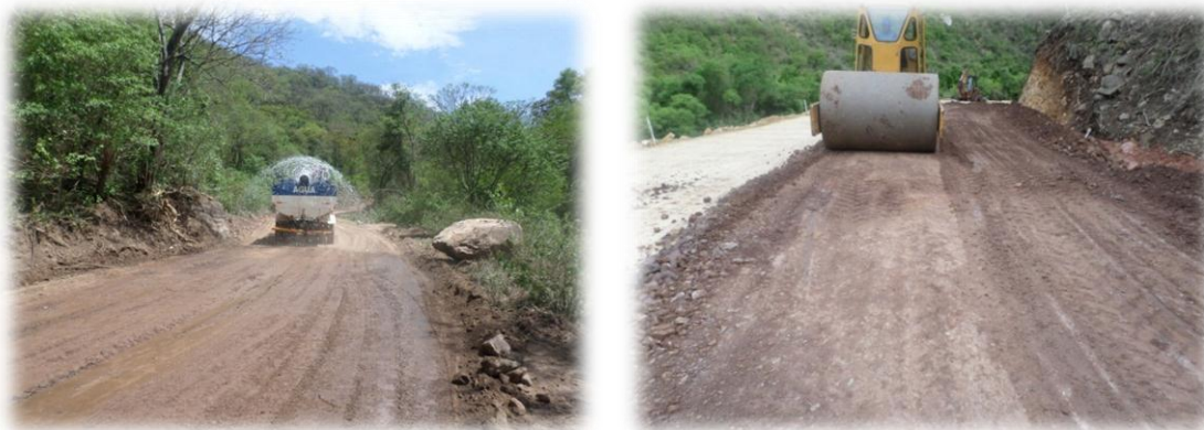
FIGURA N° 56 Compactado del material para el ripiado
