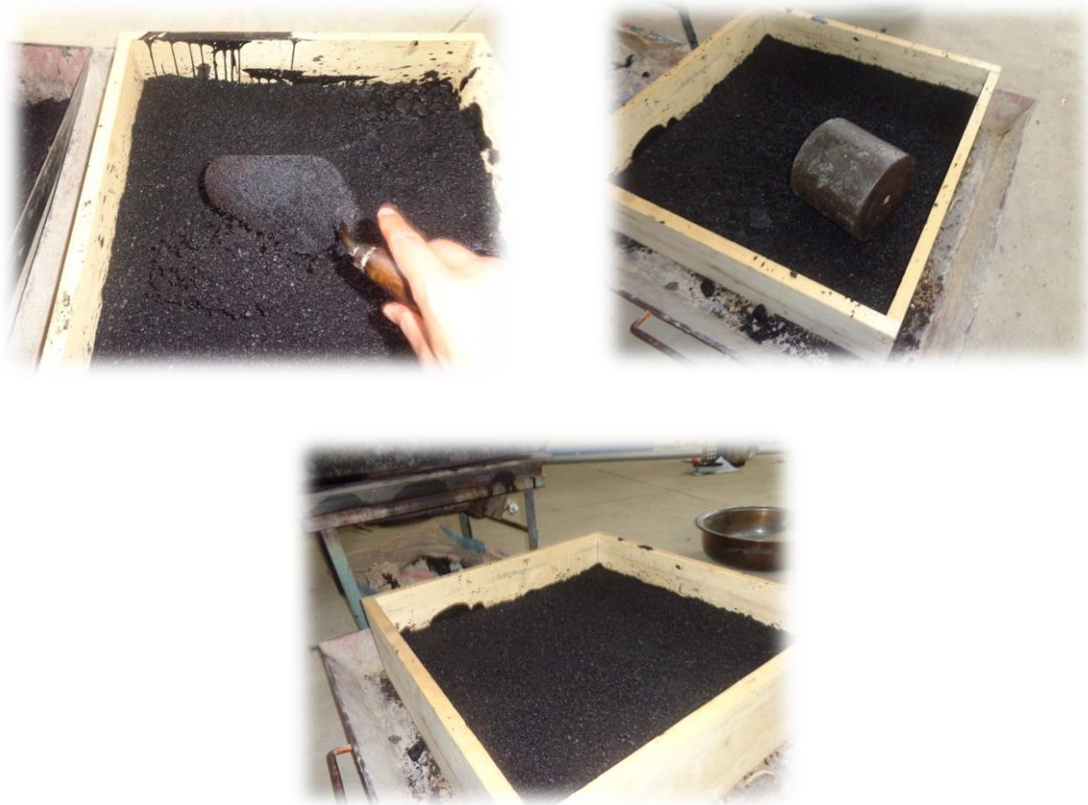
FIGURA N° 69 Procedimiento de compactado terminado
