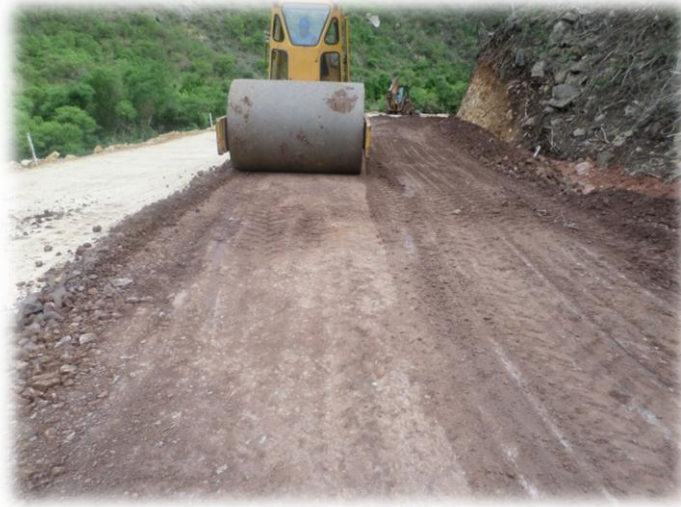
FIGURA N° 7 Compactado del material para el ripiado
