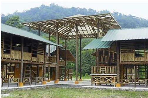
c) Est. de cubierta hecha de bambú
