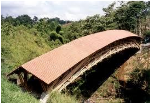
a) Puente tradicional de bambú
