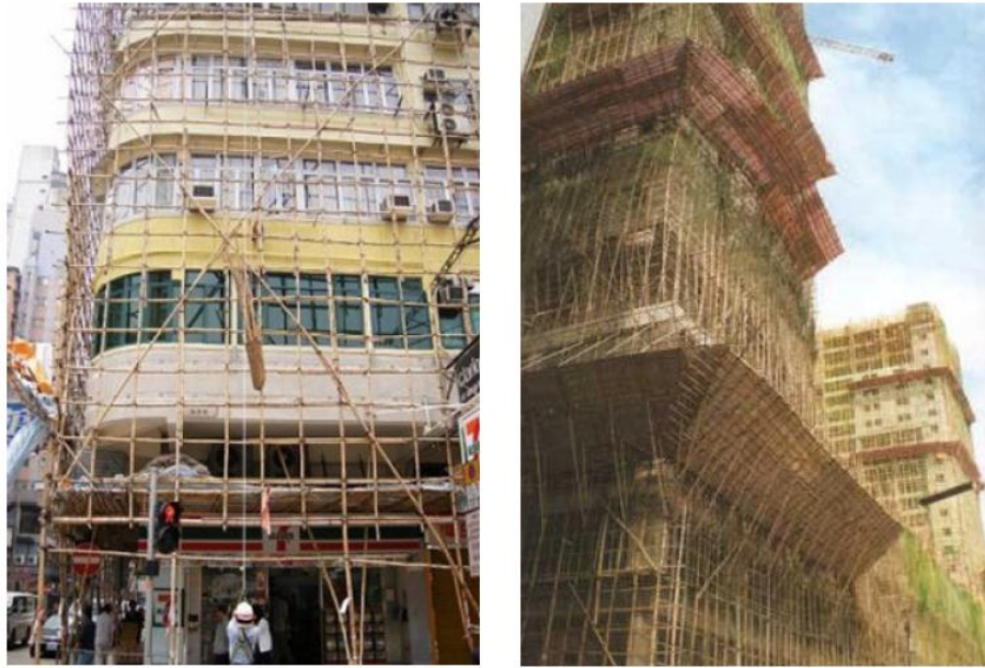
Figura 1.1 Andamios de bambú, fuente Hutchison (2002)
