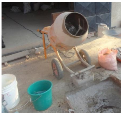
Fotografía N° 5: Hormigonera lista para empezar el mezclado.
