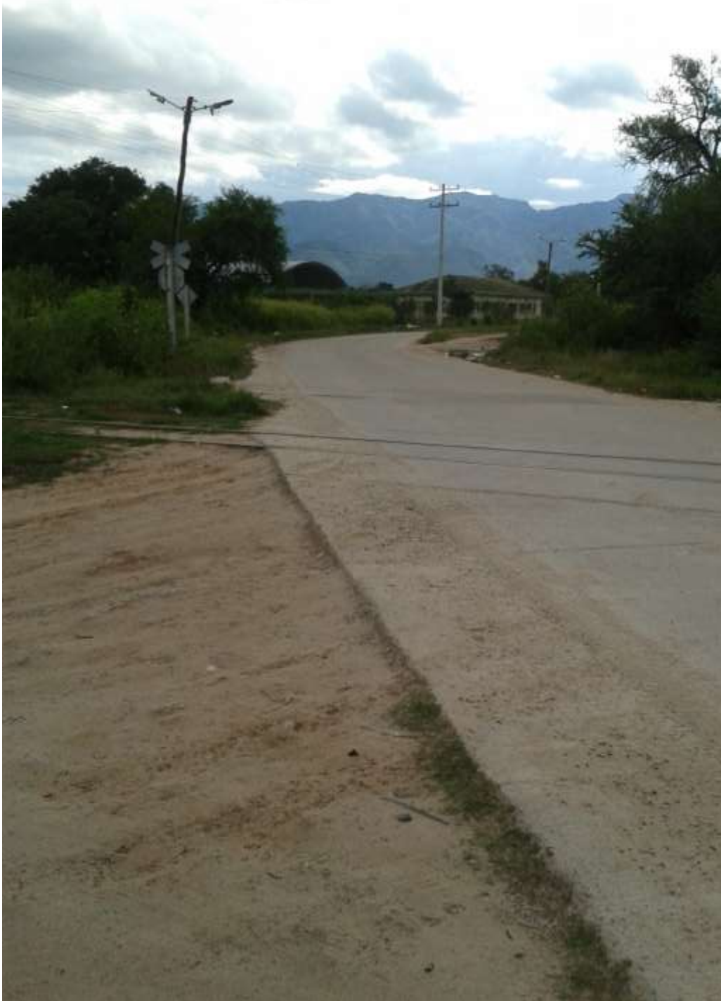
Figura 47. Paso abierto prog. 16+300.
