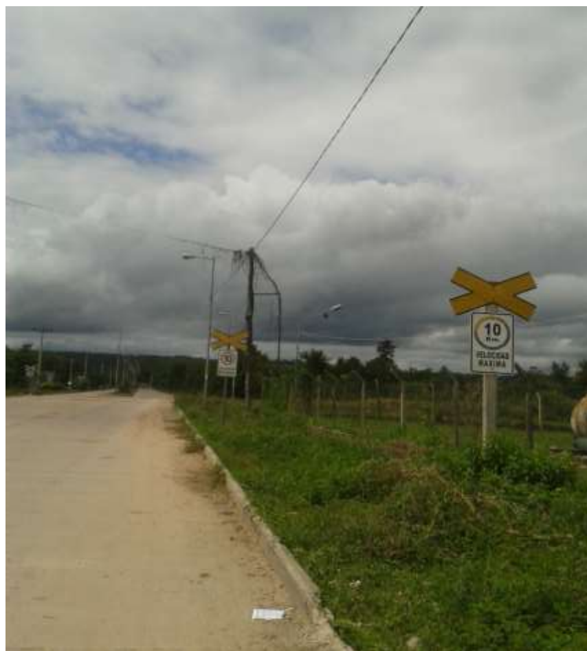
Figura 46. Señalización del Paso abierto prog. 16+300
