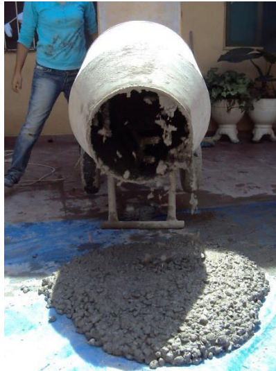
Figura 3.22. Vaciado de la mezcla de hormigón en superficie plana. (Fuente propia).
