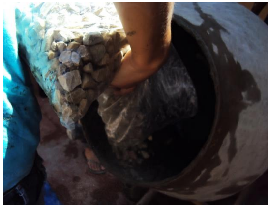
Figura 3.21. Incorporación del agregado grueso a la mezcladora mecánica de paletas verticales. (Fuente propia).
