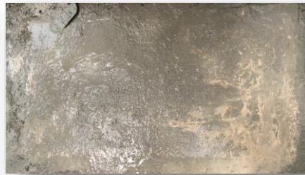
Vaciado del refuerzo en condición adherida
