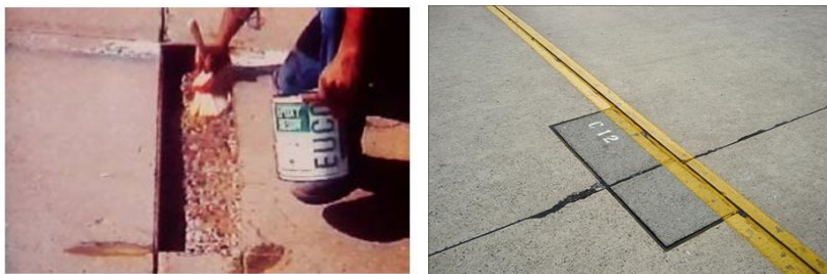
Figura 3.5 Aplicación de puente de adherencia en reparación*
