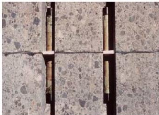
Figura 3.7 Colocación de pasadores*
