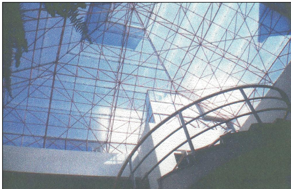
FIGURA N° 3. 40 CUBIERTA EN ESTÉREO ESTRUCTURA DEL EDIFICIO “ZUBER” EN LA CIUDAD DE COCHABAMBA
