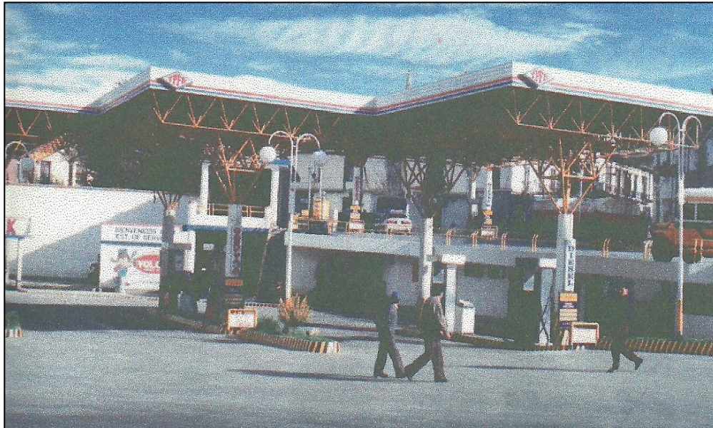
FIGURA N° 3. 39 CUBIERTA EN ESTÉREO ESTRUCTURA DE LA ESTACIÓN DE SERVICIOS “MONTES” EN LA CIUDAD DE LA PAZ
