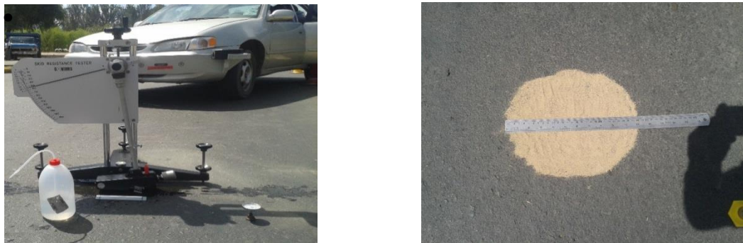
Fig. 39 Medición de la textura y C.R.D. tramo curvo-Carretera a Bermejo
