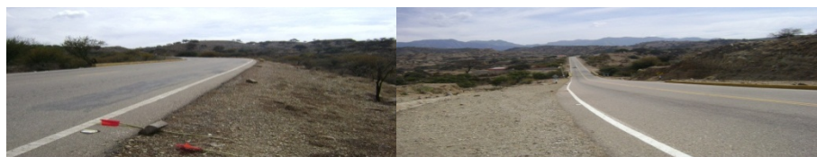
Fig. N° 23: carretera Padcaya – La Mamora
