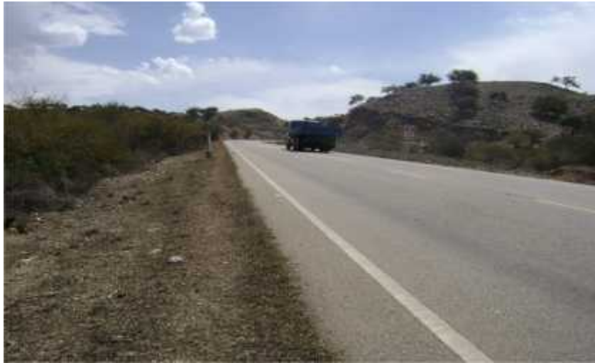
Fig. 14: Recta Hacia La Curva N° 6 Tramo Padcaya – La Mamora
