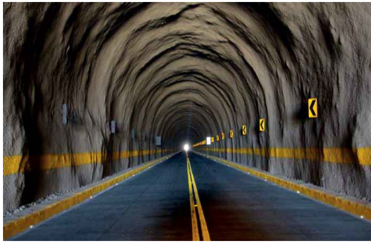
Fig N° 22: túnel Falda La Queñua
