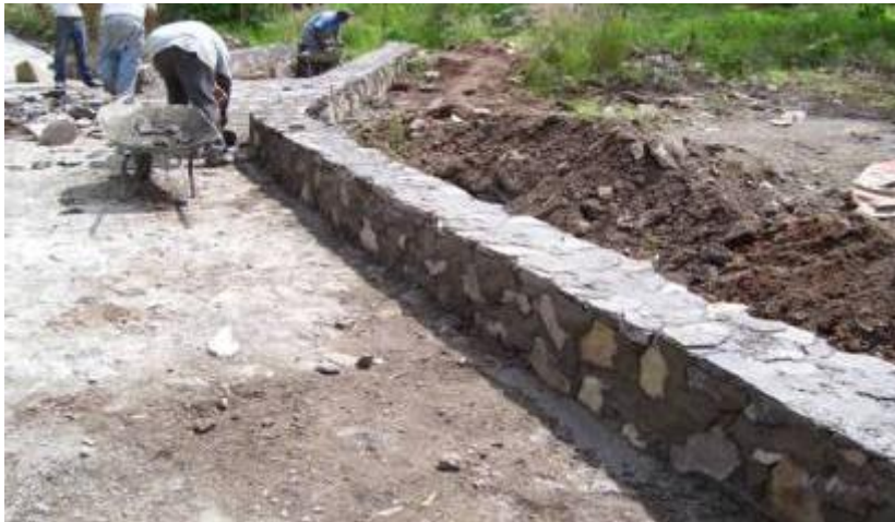
Figura 3.6: Bordillos zampeados con piedra.
