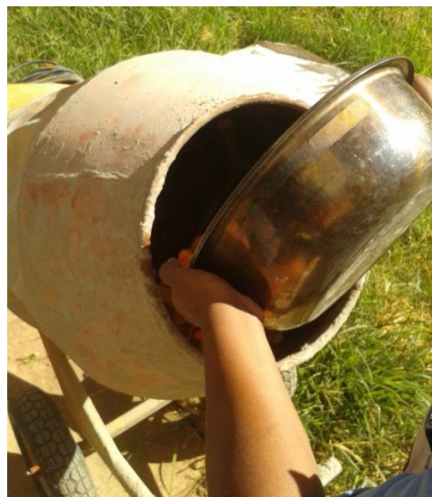
Figura 4.10: Mezcladora en proceso de elaboración del hormigón.
