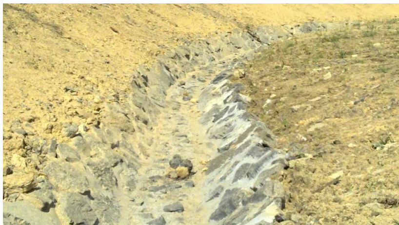
Figura 3.5: Cuneta zampeada con piedra.
