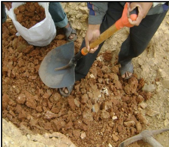
Sondeo de muestras Progresiva: 13+500
