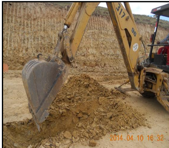
Sondeo de muestras Progresiva: 15+500
