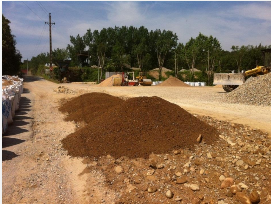
Estabilización mecánica (Granulometría)
