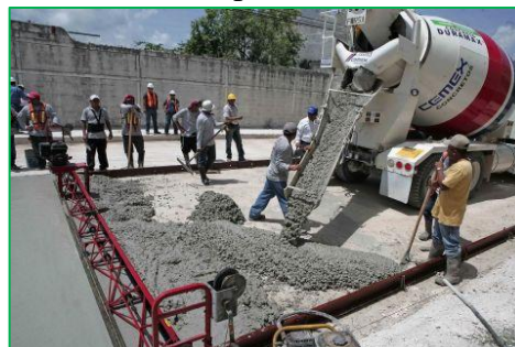
Fig. (b) Hormigón para pavimento (Ref. 12)
