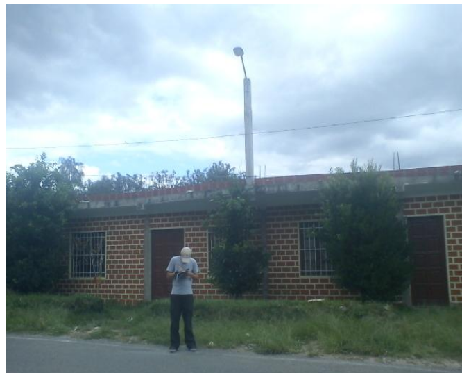
Fotografía 19.- Poste de la luminaria arriba de la loza de una vivienda
