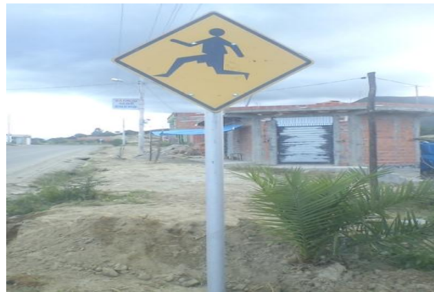
Fotografía 10.- Señal vertical alejada de la calzada
