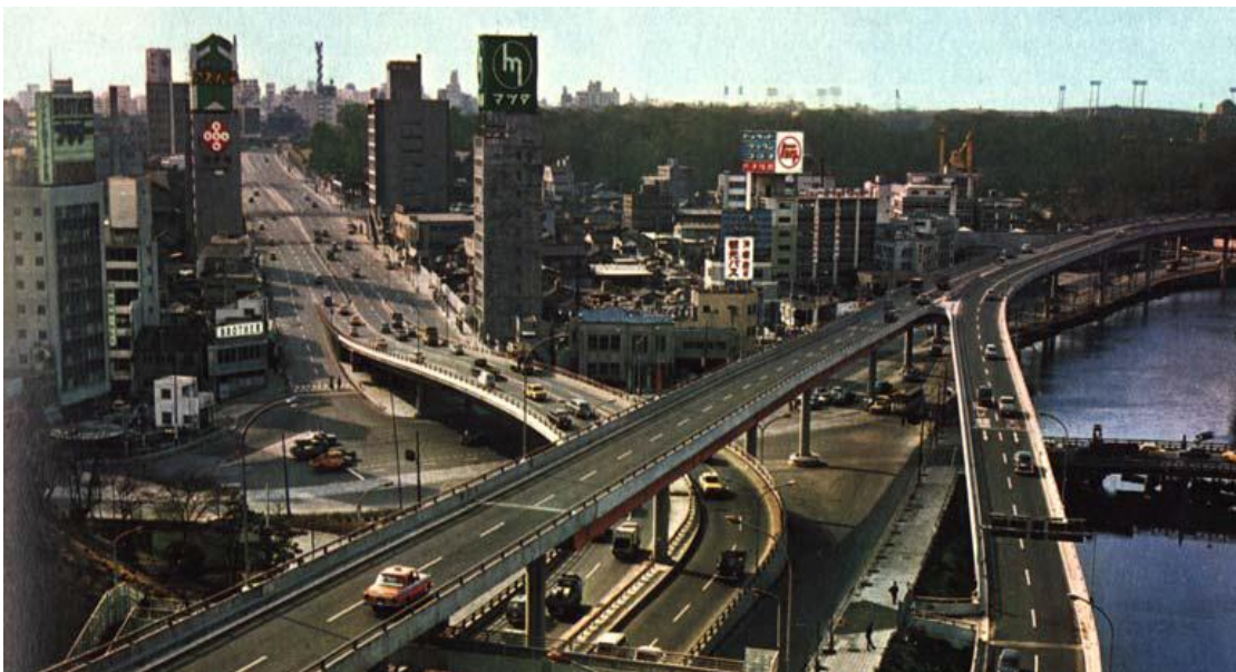
Fig. I-13. – Enlace entre una autopista elevada y la ciudad de Tokio (Japón)
