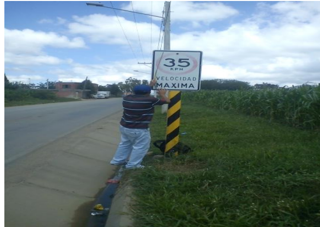
Fotografía 9.- Señal vertical en condiciones optimas
