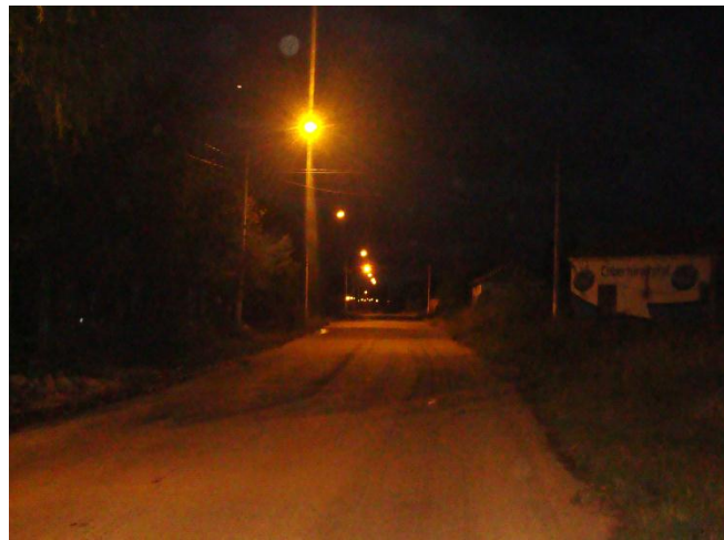
Fotografía 18.- Zona segura para la circulación
