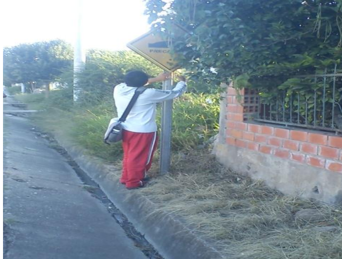
Fotografía 7.- Señal vertical cubierta de ramas
