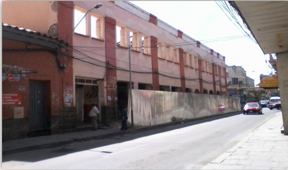
Fotografía: Mercado central en proceso de demolición
