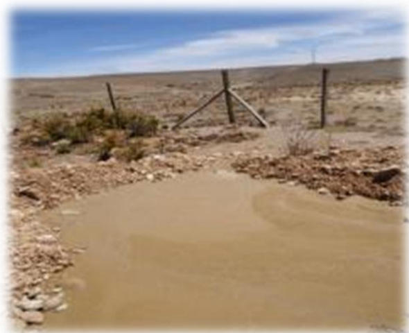
FOT. 5 Colmatación de la fosa séptica de la cocina
