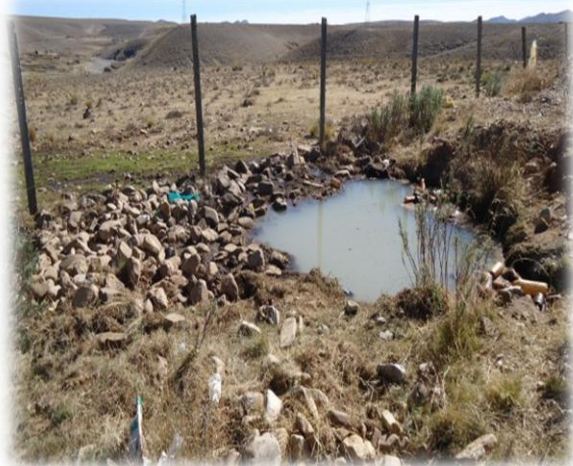
FOT.6 Falta de mantenimiento periódico de las fosas sépticas
