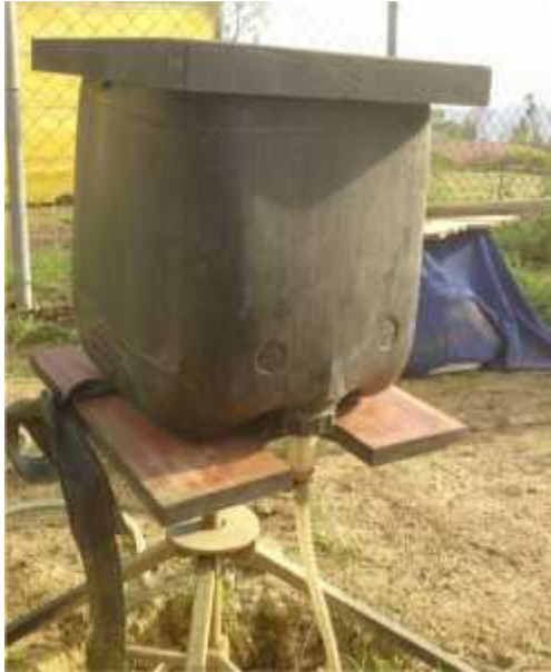
Foto 3.7.- Tanquilla de nivelación
