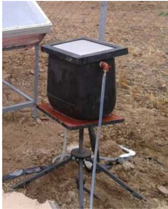
Foto 4.9.- Instalación de la tanquilla niveladora
