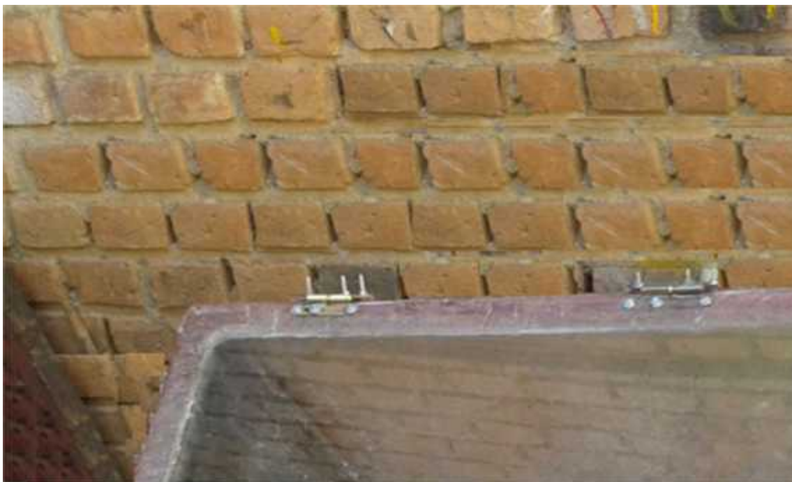
Foto 4.7.- Bisagras fijadas al módulo trapecial para mejorar su funcionalidad
