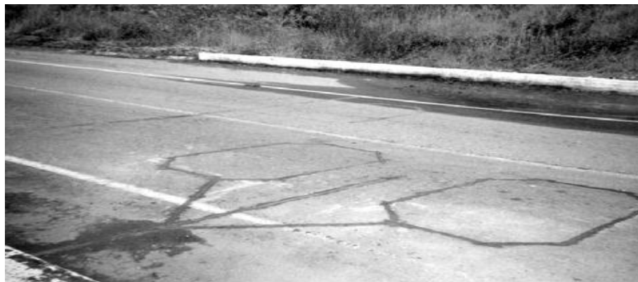
Figura 6: Sensores Piezo-eléctricos adheridos sobre el pavimento
