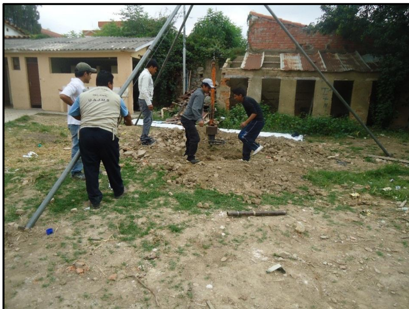
Ilustración 3: Pozo de Exploración N°1; Elaboración Propia
