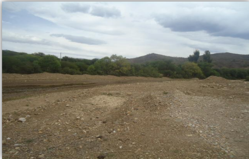
Figura- 3.6 - Banco de material “Rio Camacho”
