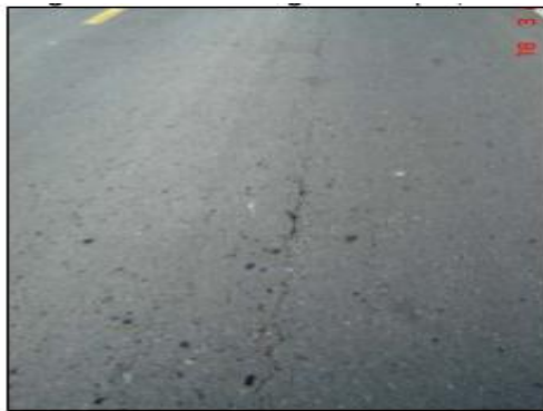
Figura 2.4.1.1.1: Fisuras longitudinal (FL)
