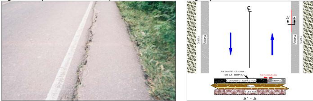
Figura 2.4.5.2.1 Separación de la berma (SB)
