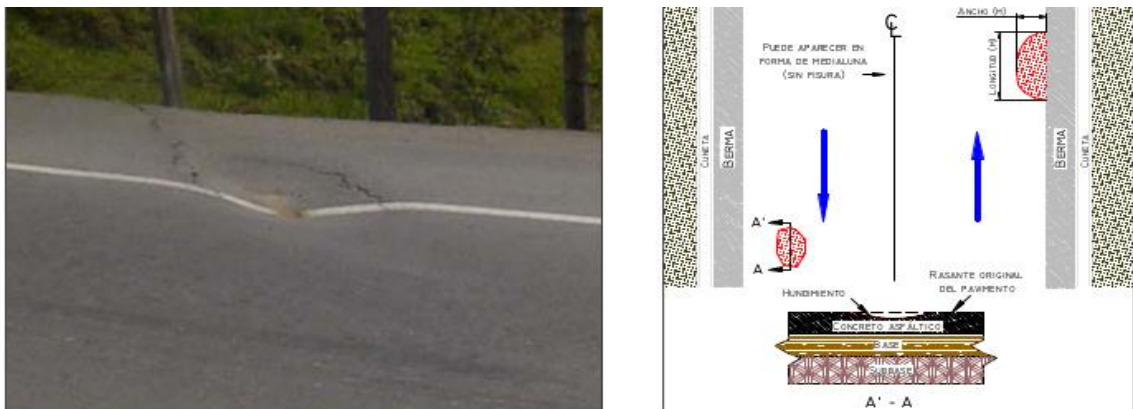
Figura 2.4.2.3.1: Hundimiento (HUN)
