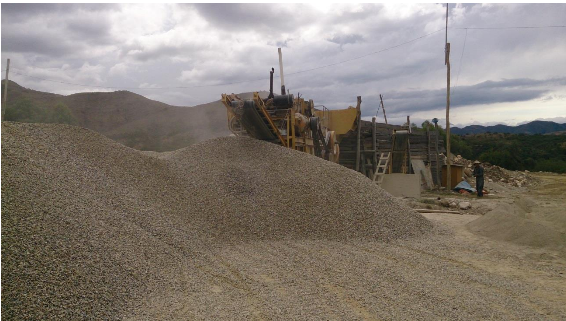
Figura 3.3 Acopio de material pétreo
