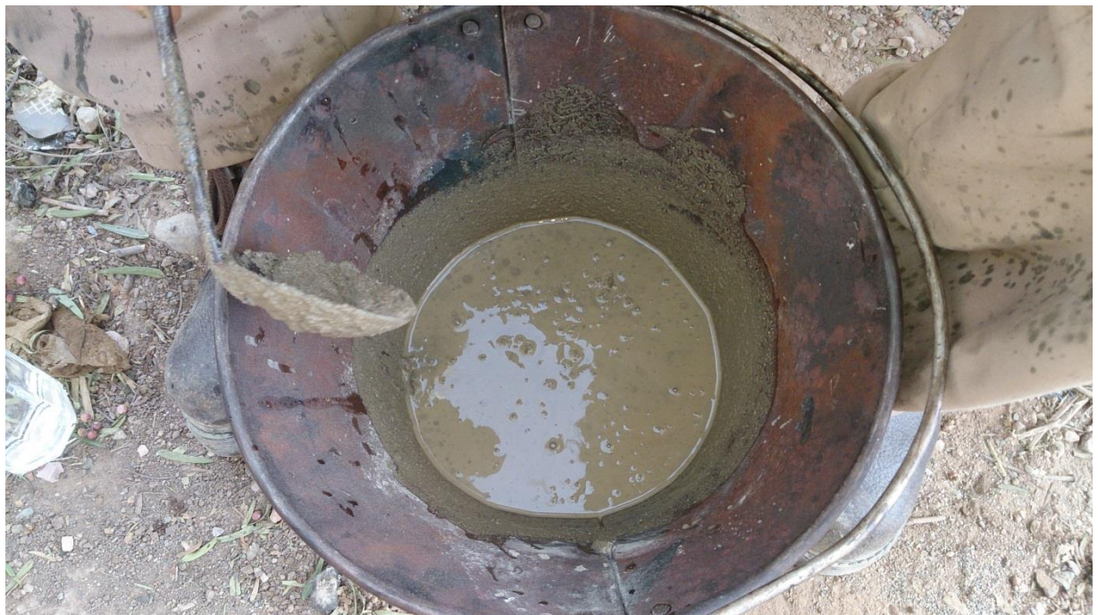
Figura 4.13 Lechada de cemento
