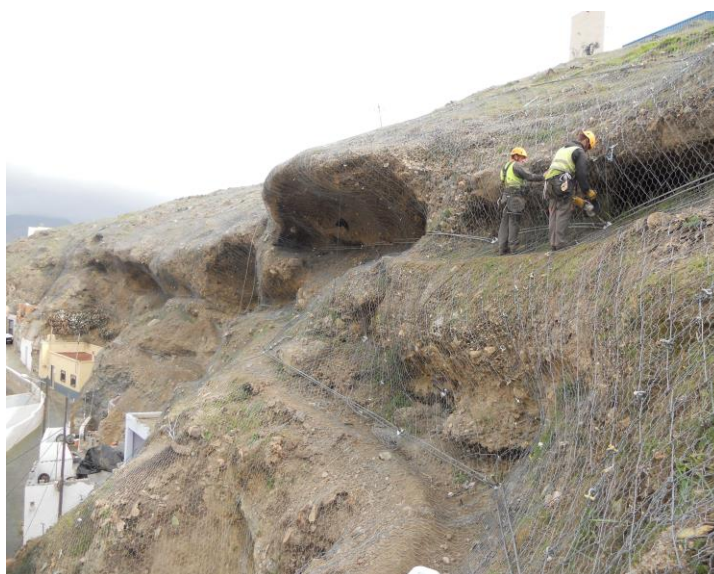
Figura 4.6.: Sistema de Estabilización Red de Cables Continua
