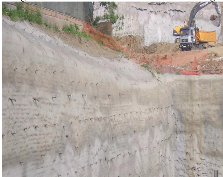
Figura 4.5 : Sistema de Estabilizacion Soil Nailing
