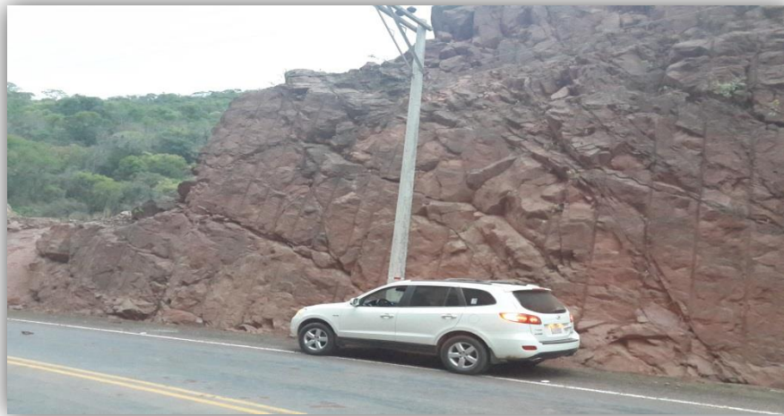
Foto 2.1. Talud de carretera corte
