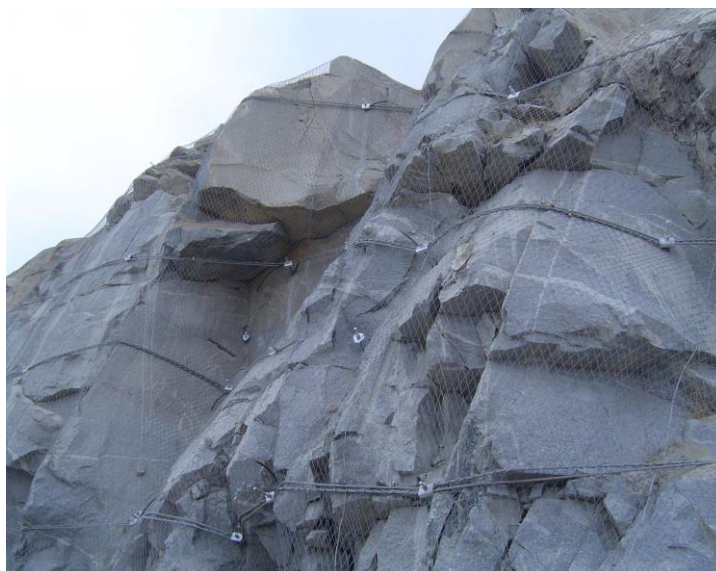
Figura 4.7: Sistema de estabilización TECCO
