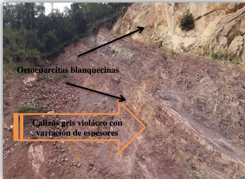
Foto 3.6 Detalle de litología talud No. 3
