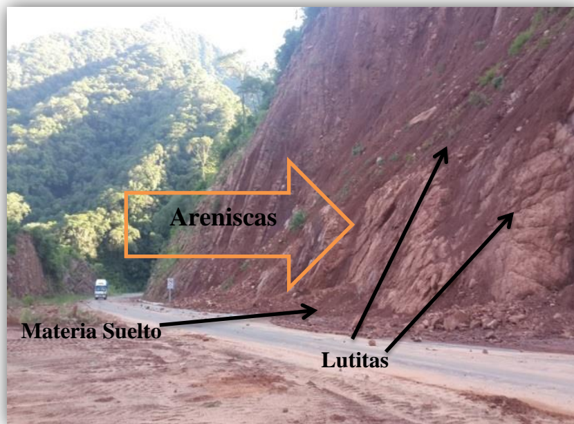
Foto 3.9 Detalle de litología talud No. 6
