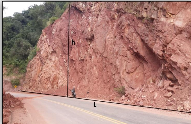
Foto 3.3. Toma de datos Geométricos del Talud con Estación Total.
