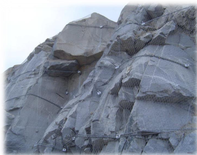
Figura 4.2: Sistema de estabilización TECCO
