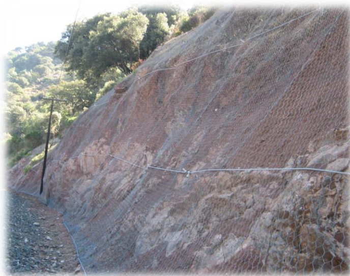
Figura 4.4: Sistema de estabilizacion Malla TT reforzada
