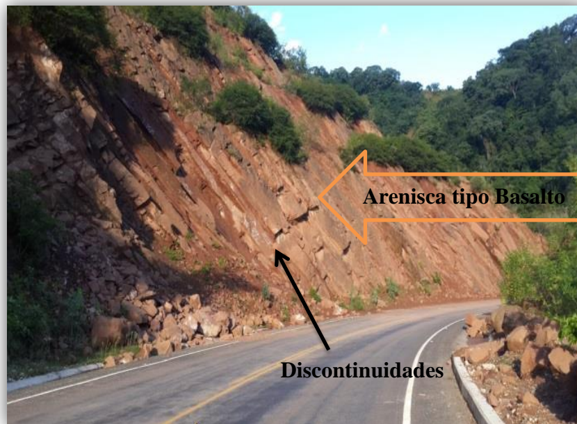
Foto 3.12 Detalle de litología talud No. 9
