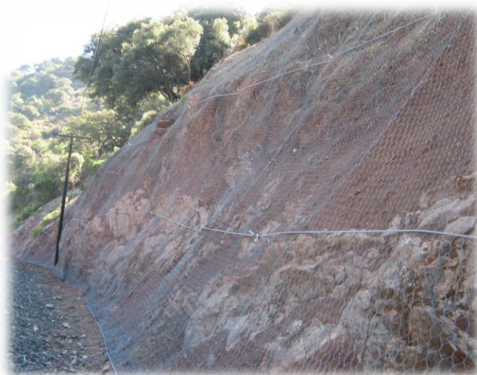
Figura 4.3: Sistema de estabilizacion Malla TT reforzada
