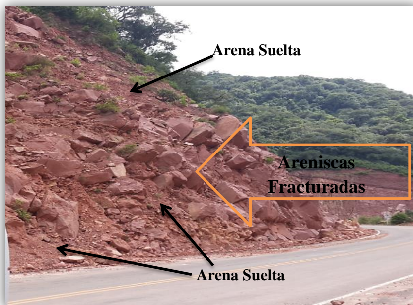
Foto 3.8 Detalle de litología talud No. 5
