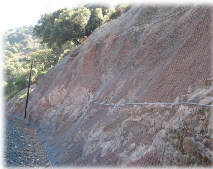
Figura 4.1: Sistema de estabilización Malla TT reforzada
