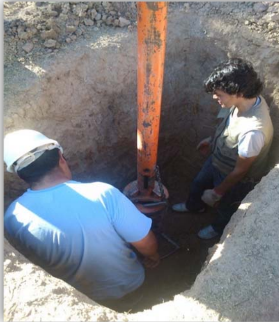
Figura 3.30: Realización del ensayo
