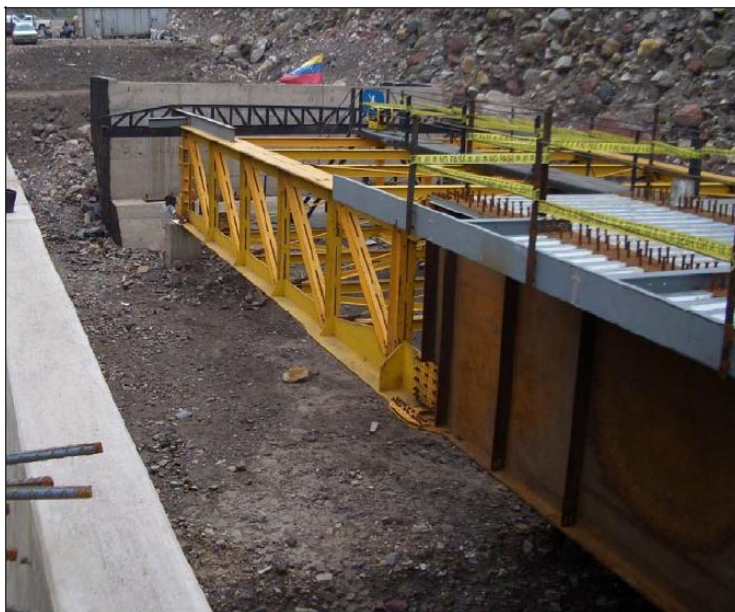
Gráfico 18- La nariz se desmonta una vez terminado el empuje. Fig.
