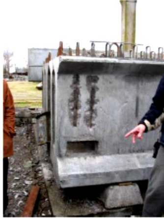
Gráfica 7.- Pases para armadura de vigas transversales
