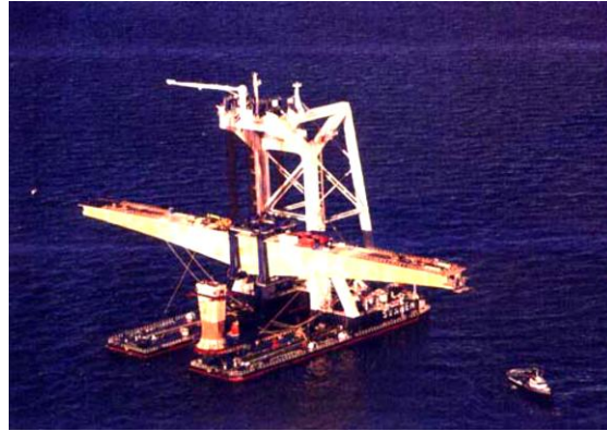
Gráfica 4.- Puente de la Confederación Montaje de Viga (7200 ton)
