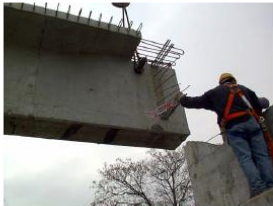
Gráfica 6.- Armaduras de espera para vigas transversales
