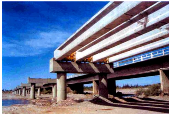
Gráfica 3.- Puente RN40 en mendosa (Utilización de vigas prefabricadas)
