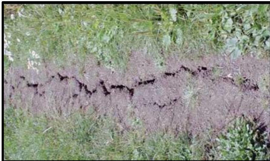
Ilustración 3. Subrasante agrietada
