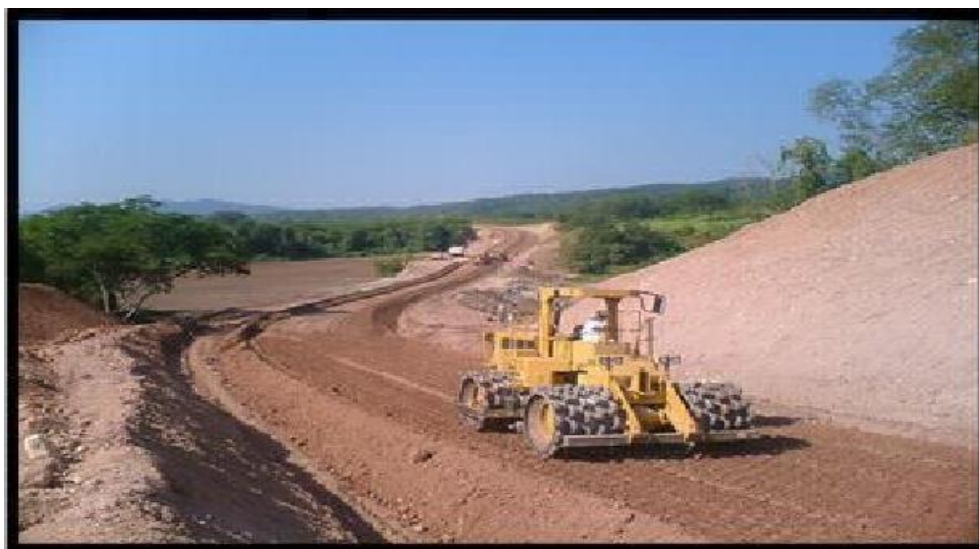
Ilustración 1. Subrasante en proceso de mejoramiento
