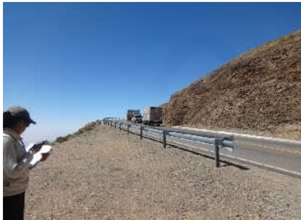
FIGURA 4 - 7: Fotografía sub tramo 2 de la Variante la Falda la Queñua.
