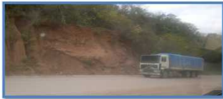
FIGURA 4 - 12: Fotografía sub tramo 3, Ojo de Agua – El Aguarague.
