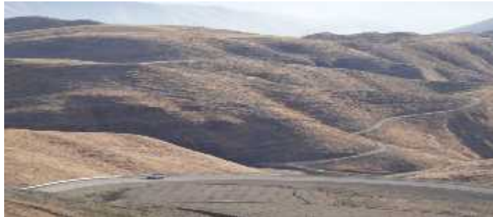
FIGURA 4 - 8: Fotografía sub tramo 2 de la Variante la Falda la Queñua.
