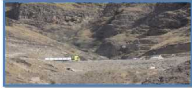
FIGURA 4 - 14: Fotografía sub tramo 2, La Concha – El túnel.
