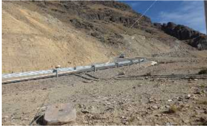
FIGURA 4 - 6: Fotografía sub tramo 1 de la Variante la Falda la Queñua.
