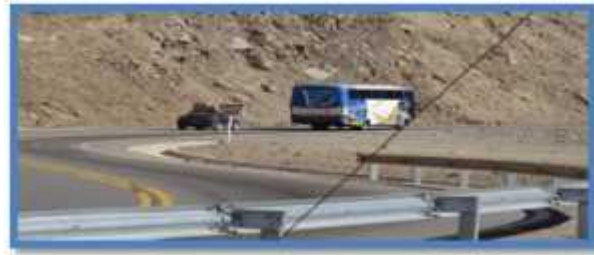
FIGURA 4 - 13: Fotografía sub tramo 1, La Concha – El túnel.
