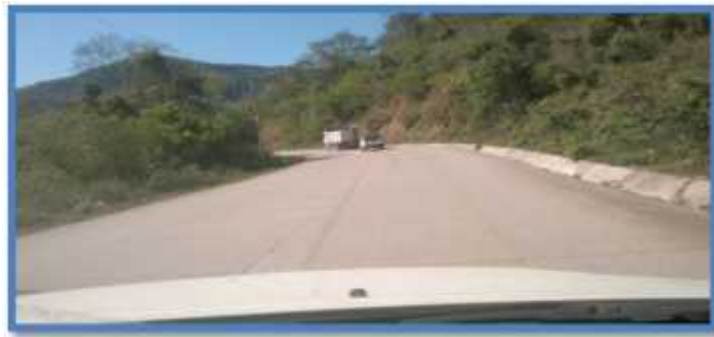
FIGURA 4 - 11: Fotografía sub tramo 2, Ojo de Agua – El Aguarague.
