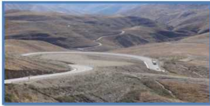
FIGURA 4 - 15: Fotografía sub tramo 3, La Concha – El túnel.
