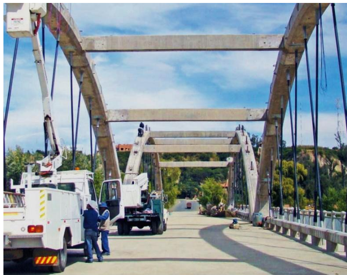
Figura 4.23. Puente de Hormigón Armado
