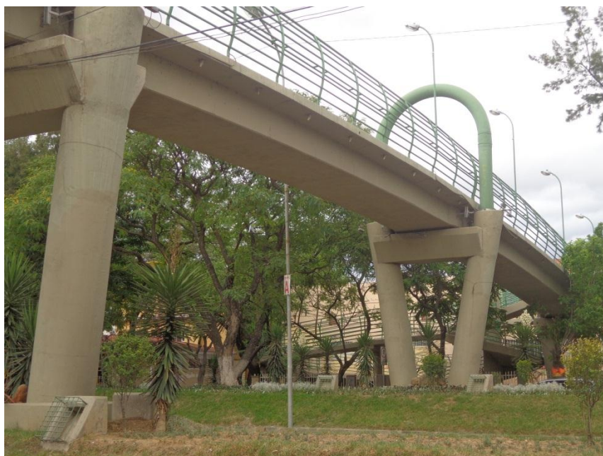
Figura 4.21. Pasarela peatonal de Hormigón
