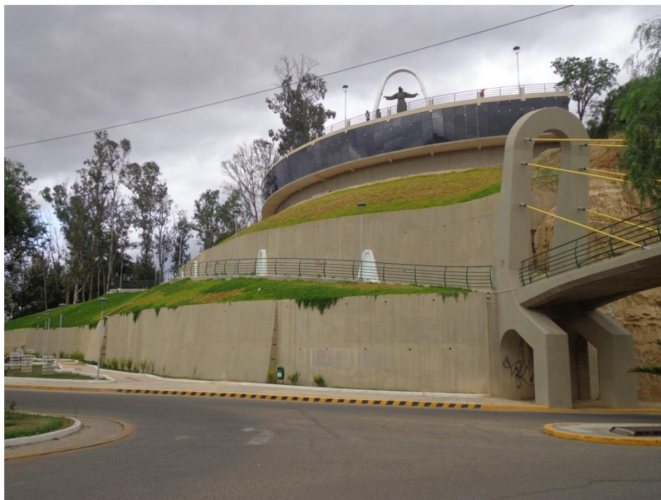
Figura 4.20. Muros de Contención del Mirador y Pasarela de Hormigón Armado en la Loma de San Juan
