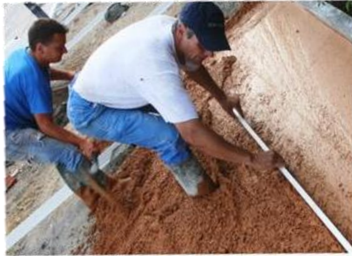
Figura 4.27. Mezcla de Hormigón para Pavimento
