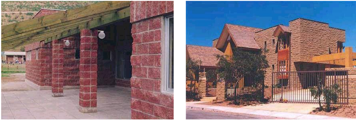
Figura 4.24. Vivienda fabricada con bloques de hormigón
