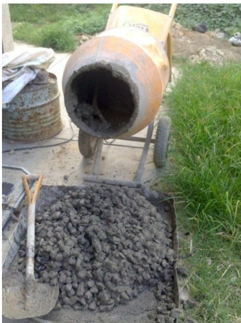
Figura 3.15 Finalización del proceso de mezclado
