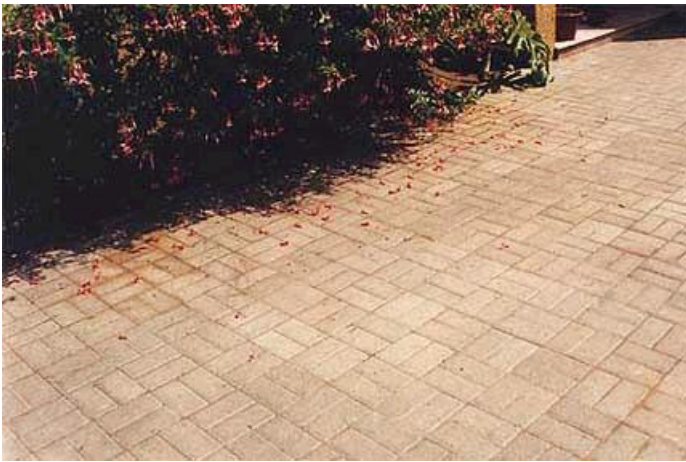
Figura 4.26. Adoquines en acceso vehicular
