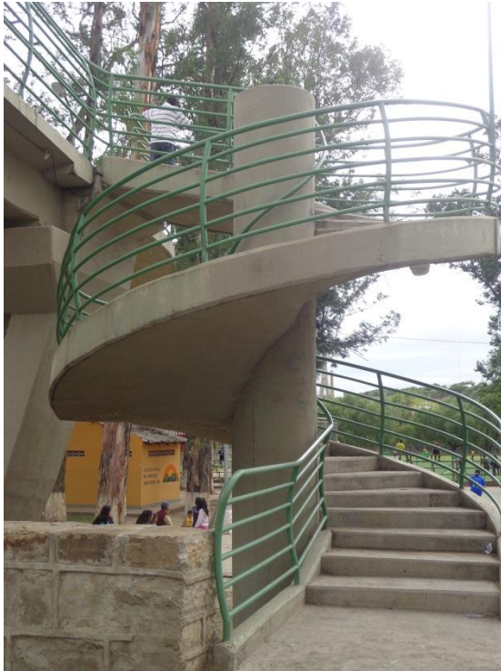
Figura 4.22. Gradas de hormigón en ingreso de pasarela
