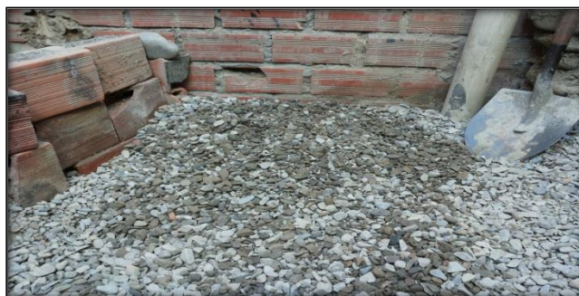
Figura 2.4. Acopio de grava para el hormigón
