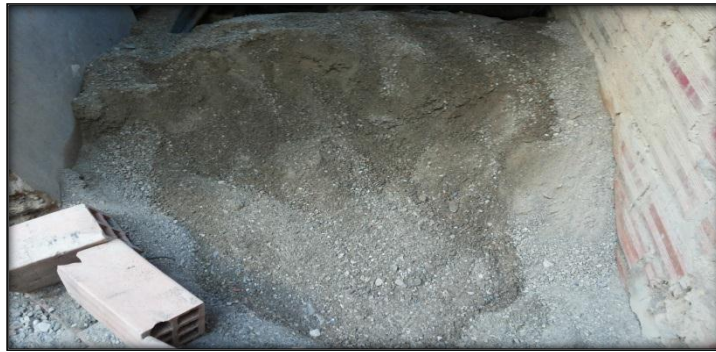
Figura 2.5. Acopio de arena para el hormigón
