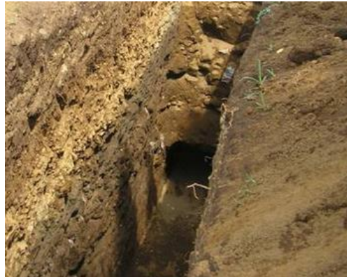
Figura 2.32. Excavación de suelo limoso
