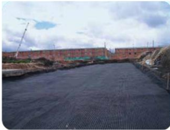
Figura 2.16. Geomalla para estabilizar suelos blandos Ciudadela Cafam-Bogotá, 2005
