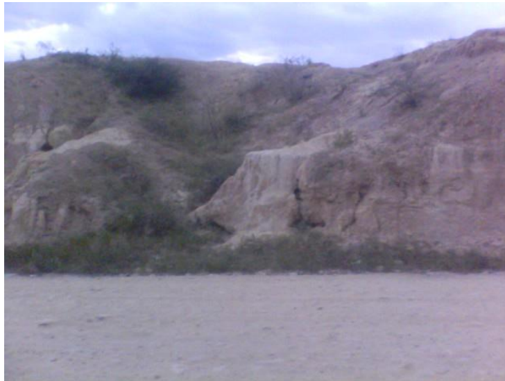
Figura 3.3. Talud de extracción
