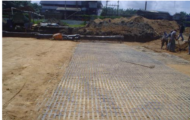
Fig. 2.19. Colocación de una capa de Geogrilla
