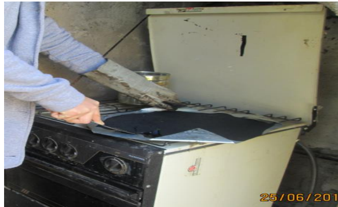
Figura N°62 Calentado de lámina y extracción del cemento asfáltico
