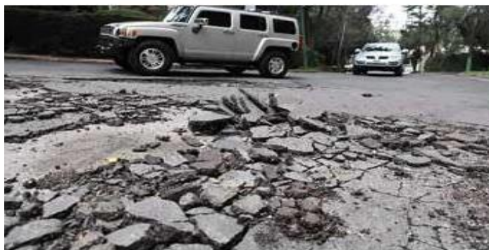
Figura N° 7 Estructura dañada por la humedad
