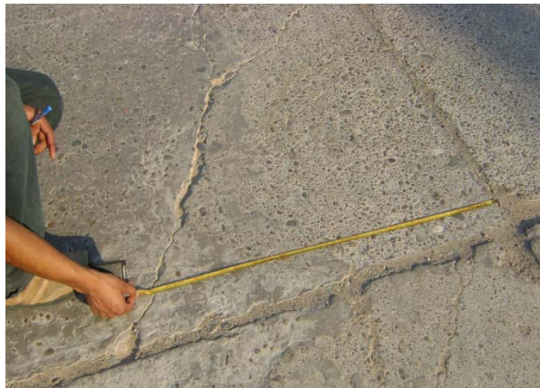
Fig. 4.5 Fisura de Esquina
