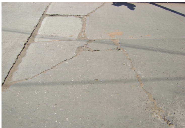
Fig. 4.11 Hundimiento
