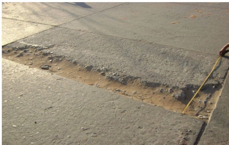
Fig. 4.21 Parchados y Reparaciones
