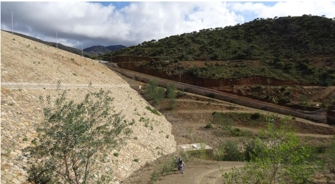
Figura 5. 3. Vista de aguas abajo de la presa y el aliviadero de la presa Calderas.
