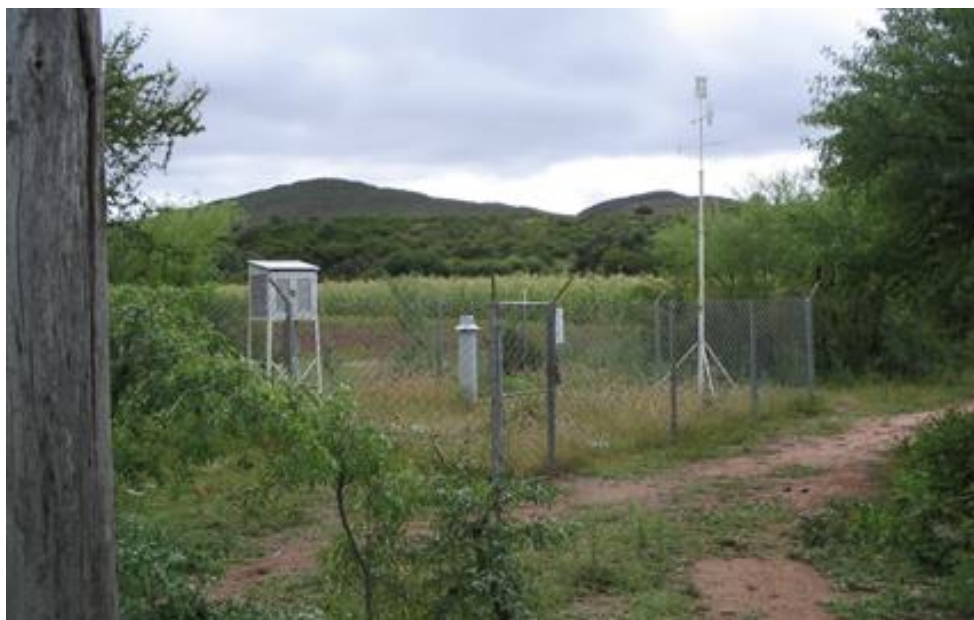
Figura 5. 6. Estación climatológica instalada por la OTN en Yesera Norte, cerca de la confluencia del río Calderas en el río Yesera.
