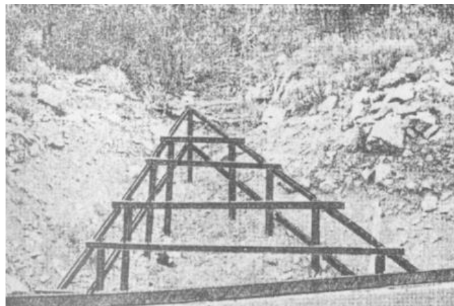
Fotografía 2.3. Deflector de arrastre emplazado.
