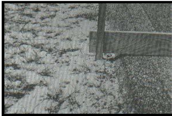
FIGURA 25 Desnivel calzada severidad alta
