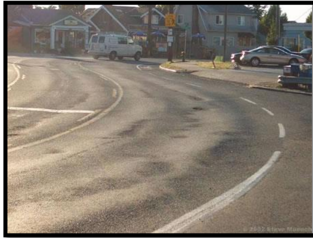
FIGURA 42 Deformación por empuje severidad media
