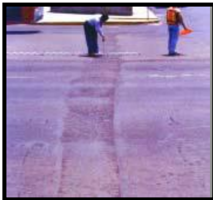
FIGURA 30 Baches y zanjas reparadas severidad media
