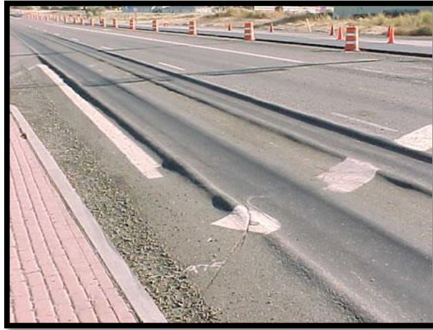
FIGURA 41 Ahuellamiento severidad alta
