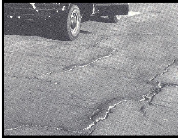
FIGURA 11 Exudación de asfalto severidad alta
