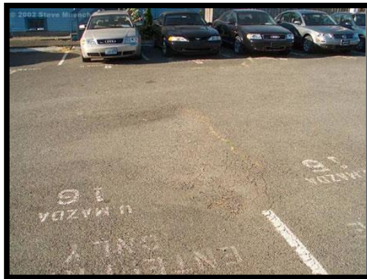
FIGURA 12 Elevación - hundimiento severidad media
