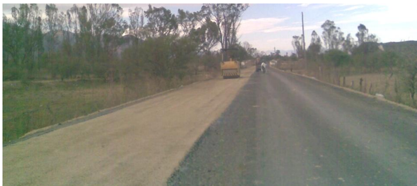
Figura N° 3.3 Compactado De una Capa
