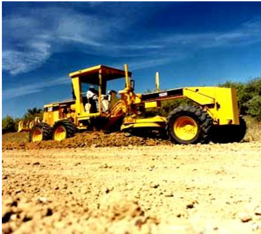
Figura N° 3.7 Preparación Del Terreno
