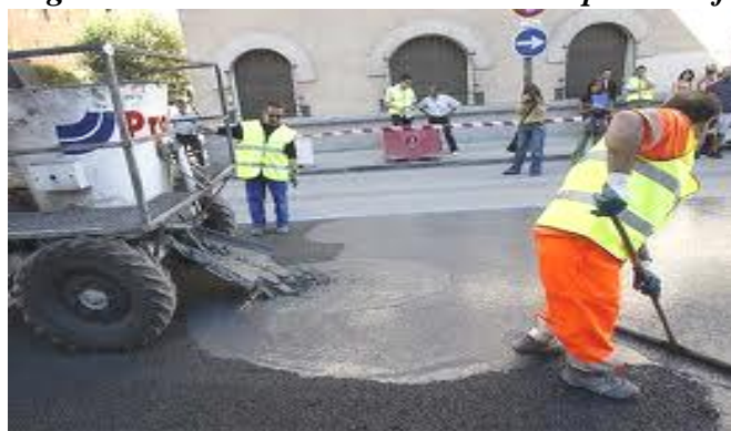
Figura N° 1.8 colocado de uno de los tipos de asfaltos
