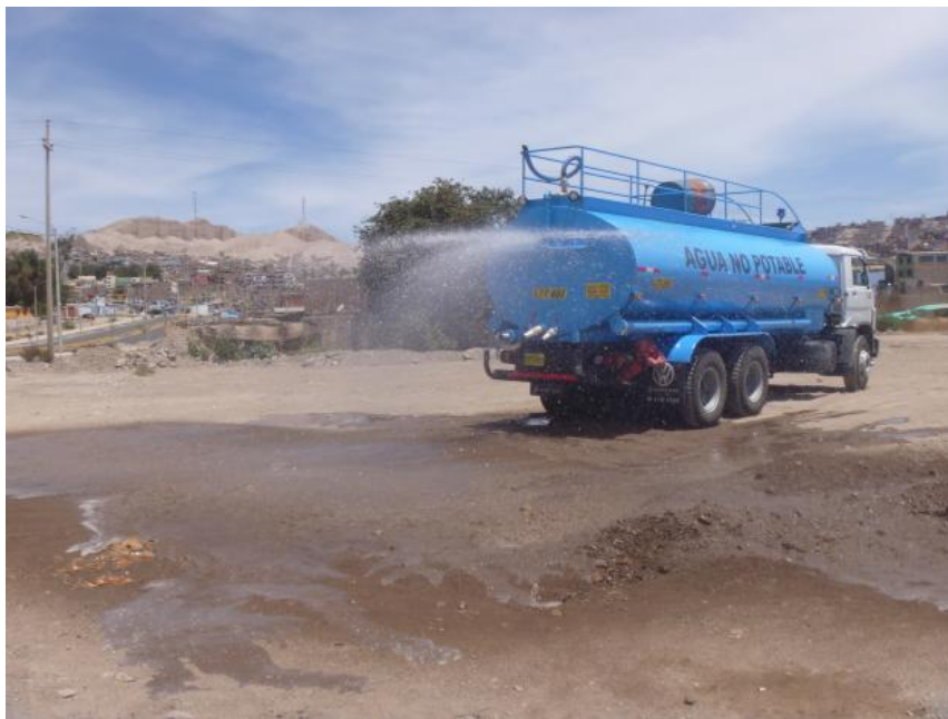
Figura N°3.8 Humedecimiento con camión tanque cisterna y barras de rociado a gravedad
