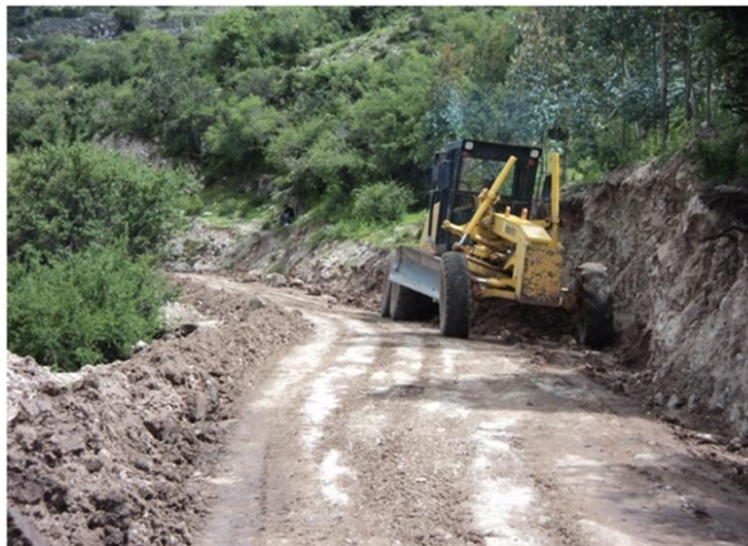
Figura N° 3.5 Problemas En Materiales De Subrasante
