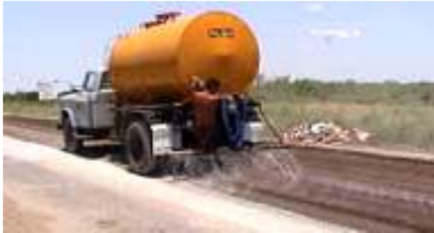
Figura N°3.9 Humedecimiento con camión tanque cisterna
