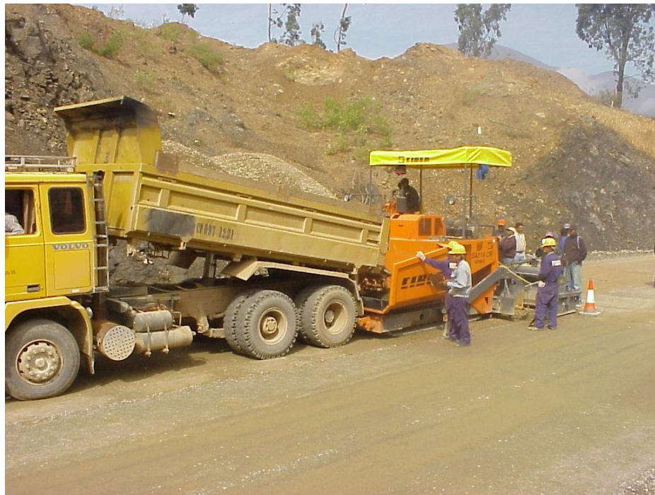
Figura 3.12 Maquina Distribuidora De Material De Base
