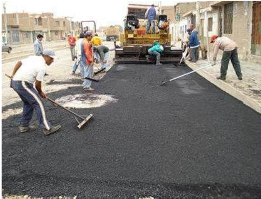
Figura N°3.11 Extendido Del Agregado Por Capas
