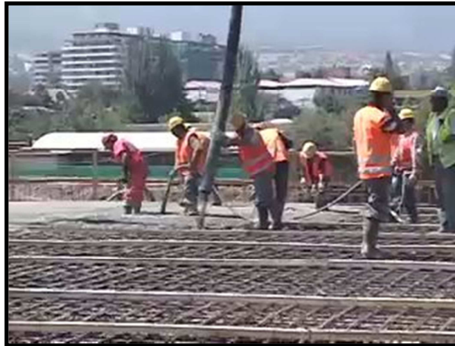
Figura 4.10 Tablero Hormigonado In Situ.
