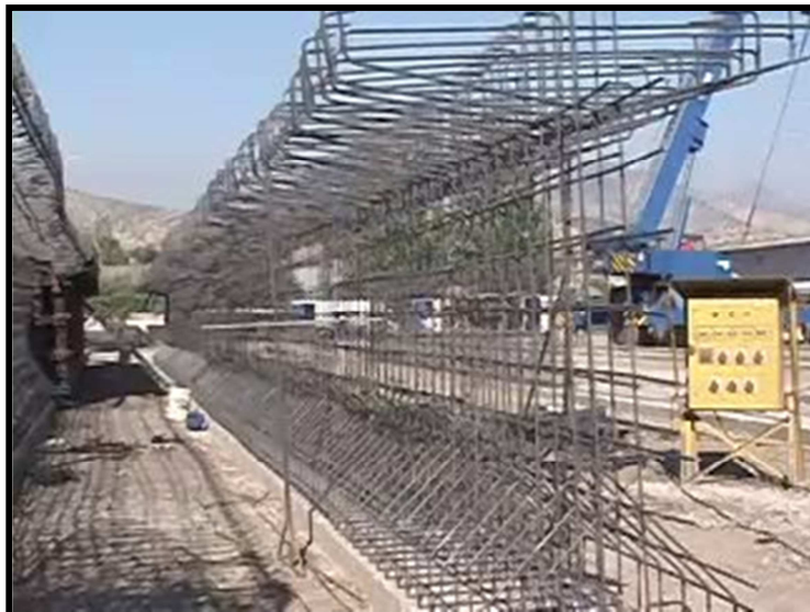
Figura 4.1 Disposición de las Armaduras de Diseño.
