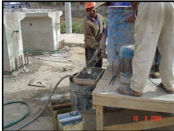
Figura 4.6 Inyección de Lechada de Cemento.
