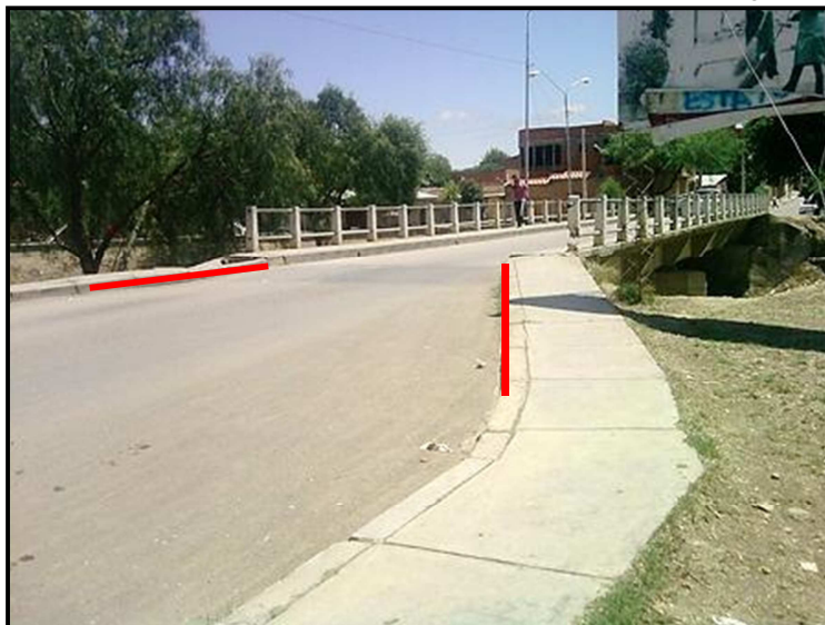
Figura 1.3 Calle Santa Cruz - Puente Vehicular 6 de Agosto.
