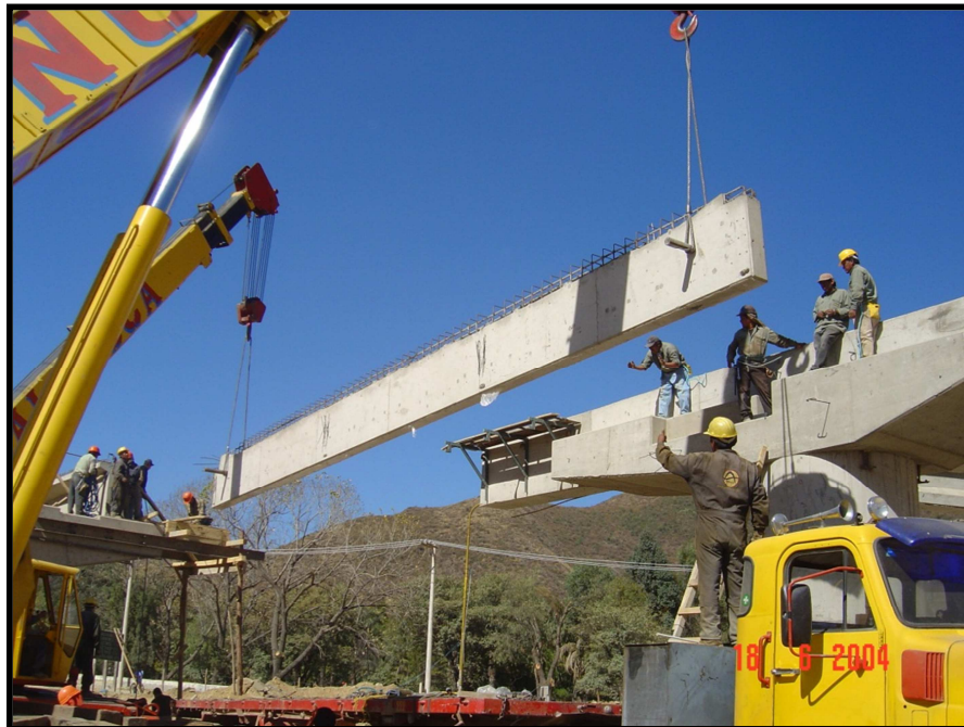
Figura 4.8 Lanzamiento de Vigas.
