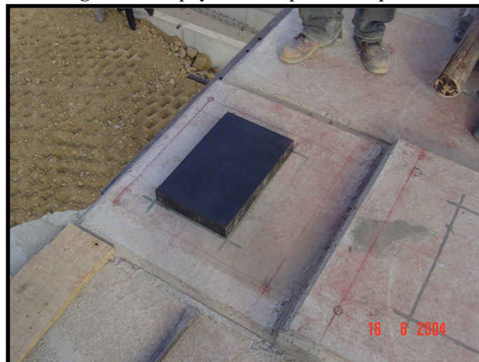
Figura 4.7 Apoyos de Neopreno Compuesto.
