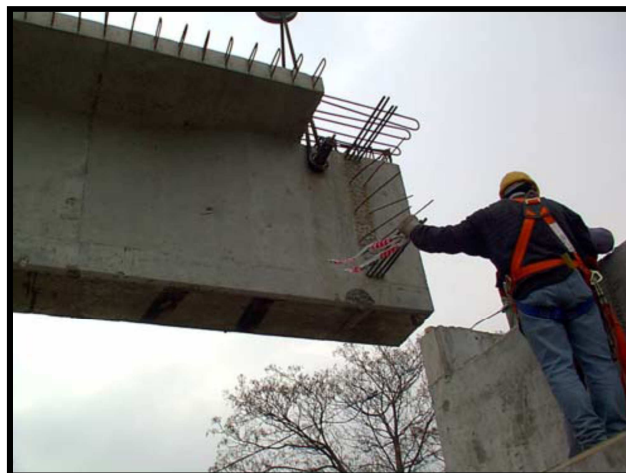
Figura 4.11 Armaduras de Espera para las Vigas Transversales.
