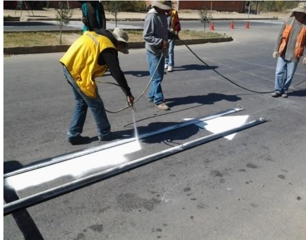
Figura 4.13.2 Fotografía del proceso de ejecución de marcas viales
