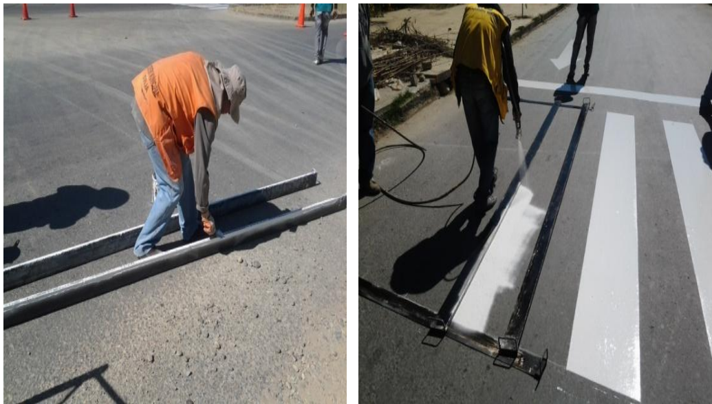
Figura 4.13.3 Fotografía del proceso de ejecución de marcas viales
