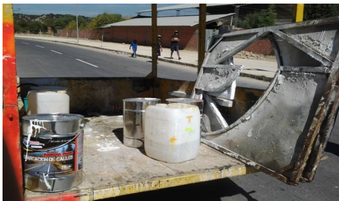
Figura 4.12 Fotografía de los materiales empleados en ejecución de las Marcas
