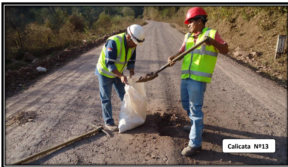
Figura 4.14. Progresiva 0+6000, eje del camino.
