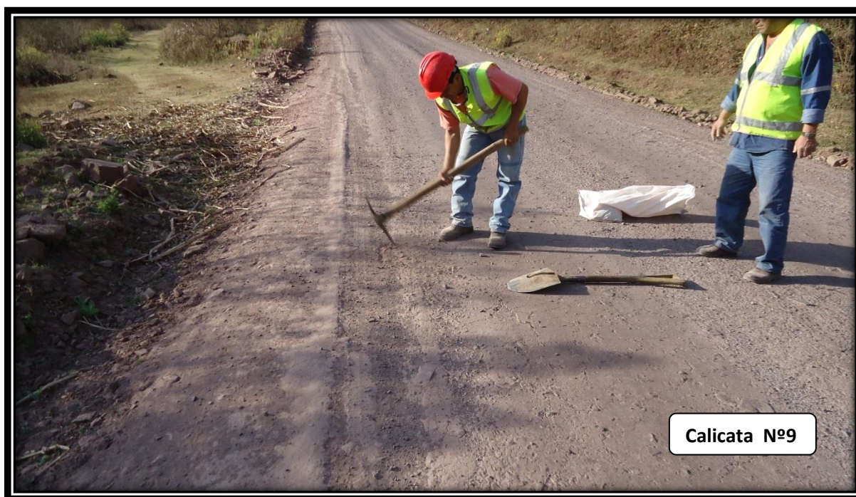
Figura 4.10. Progresiva 0+4000, lado izquierdo del camino.
