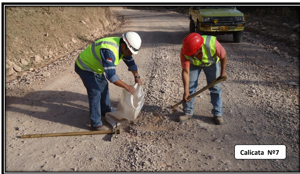
Figura 4.8. Progresiva 0+3000, eje del camino.
