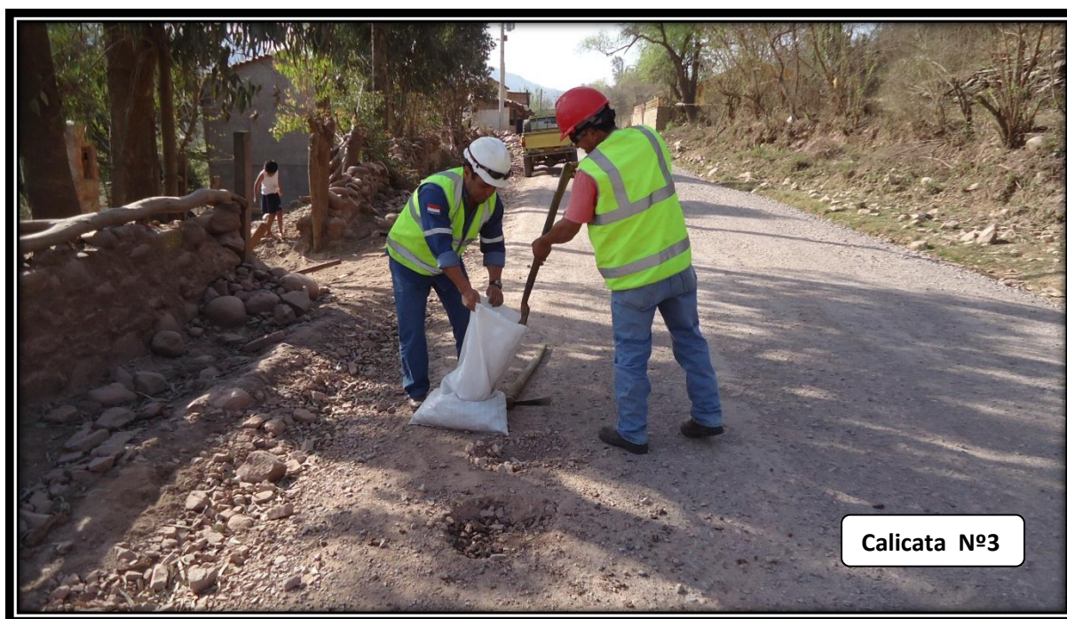
Figura 4.4. Progresiva 0+1000, lado izquierdo del camino.
