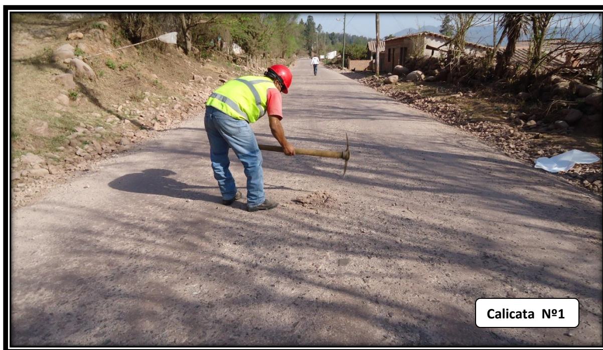
Figura 4.2. Progresiva 0+000, eje del camino.
