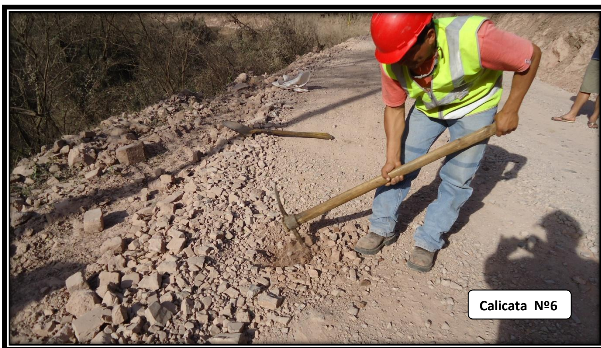
Figura 4.7. Progresiva 0+2500, lado izquierdo del camino.
