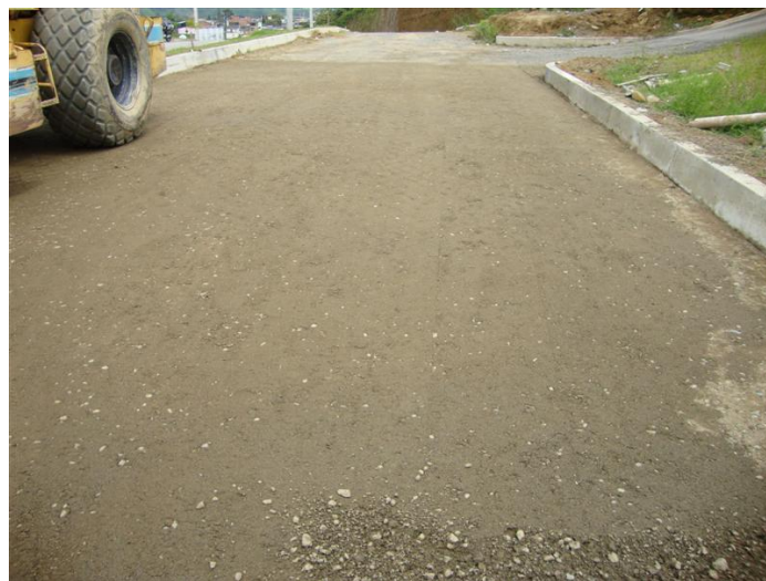
Fotografía 18. Acabado y Compactado de la Capa Subrasante
