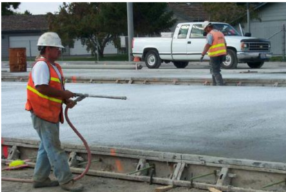
Fotografía 21. Operación del Curado del Pavimento Rígido
