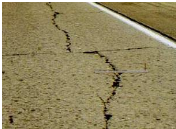
Fotografía 10. Fisuras Longitudinales
