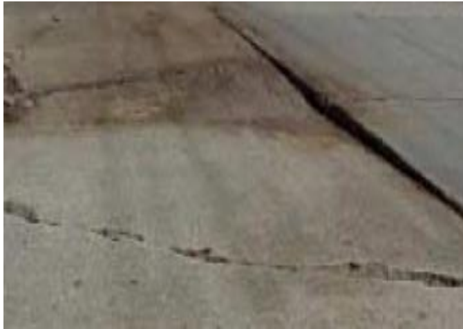
Fotografía 3. Hundimiento
