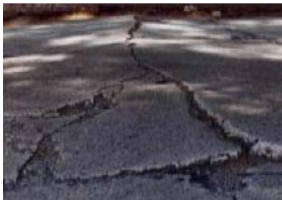
Fotografía 1. Levantamiento de Losas
