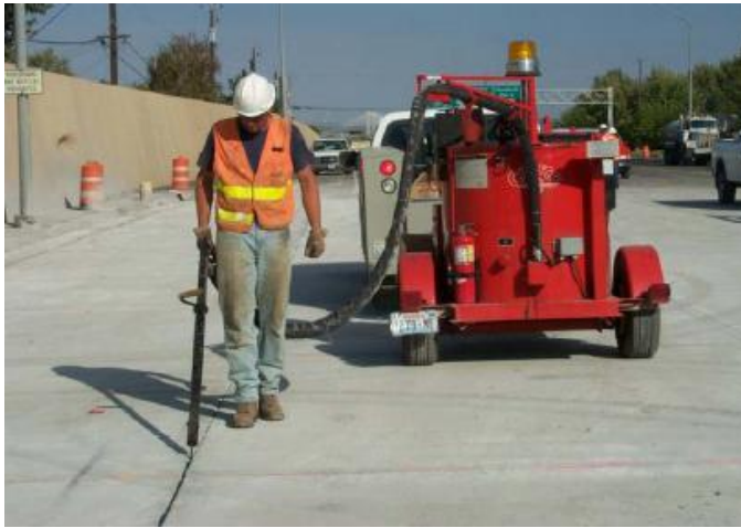
Fotografía 22. Operación Sello de Juntas
