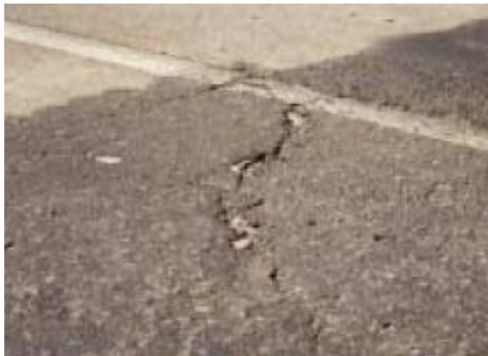
Fotografía 14. Fisuras Inducidas
