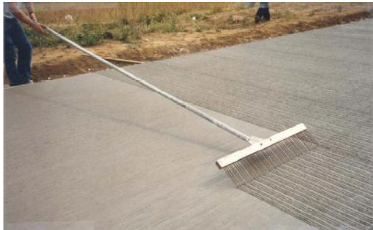
Fotografía 20. Operación de la Texturizado Final Mediante Cepillos
