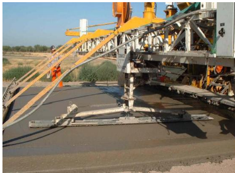
Fotografía 19. Operación de la Regla Niveladora
