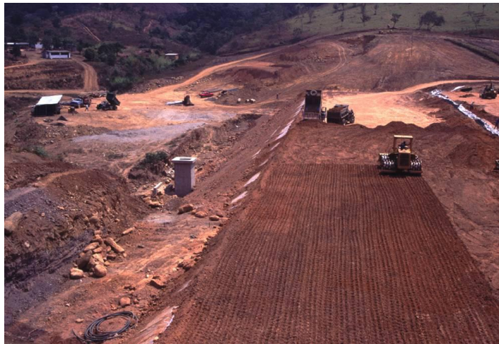
Fotografía 17. Compactación de la Subrasante con Rodillo Pata de cabra
