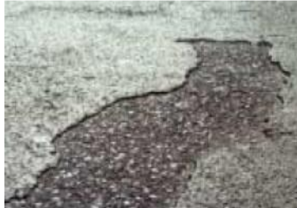
Fotografía 5. Descascaramiento
