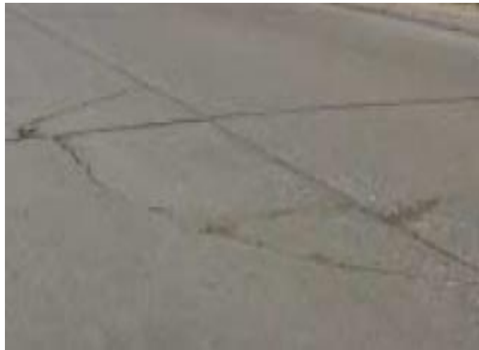
Fotografía 11. Fisuras de Esquina
