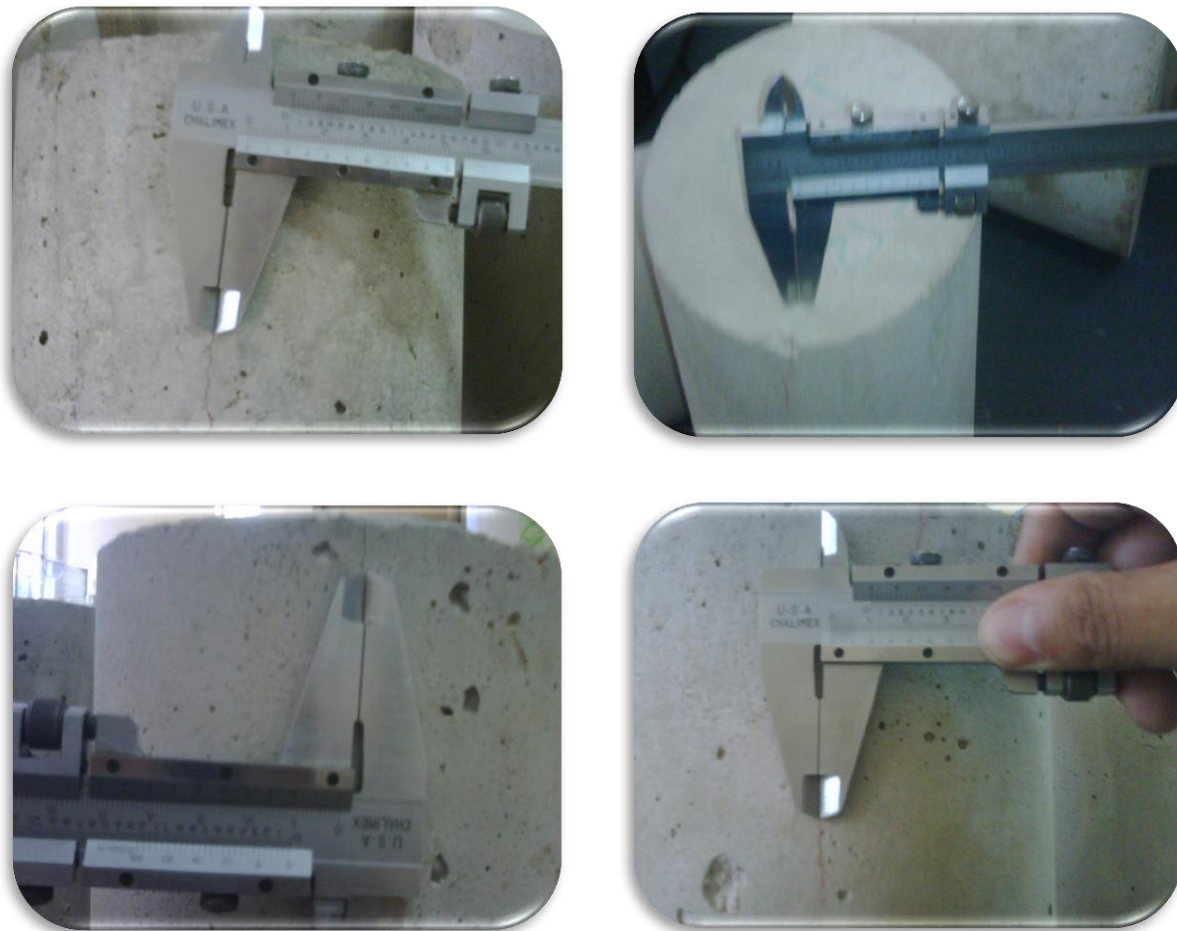
Fotografía 53. Mediciones de Ancho de Fisuras con Vernier
