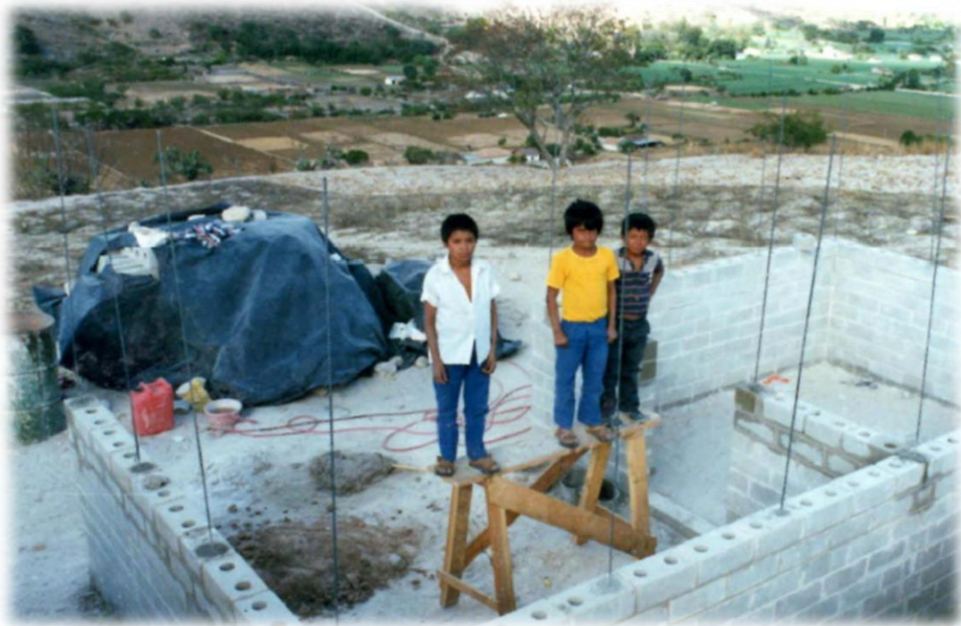
Figura N°16: Fotografía casa de Eco-ladrillos en construcción.
