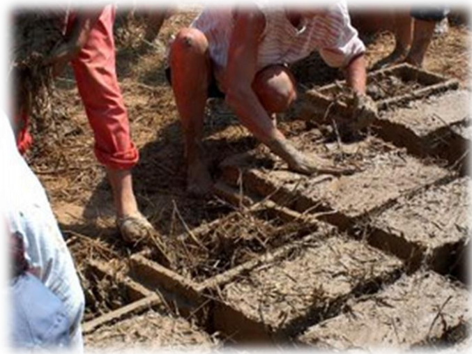
Figura N°6: Fabricación de adobes
