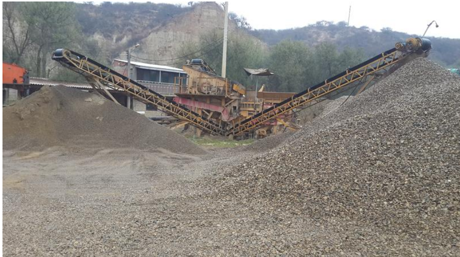
FIGURA 4.1 - Banco de material “San José de Charaja”
