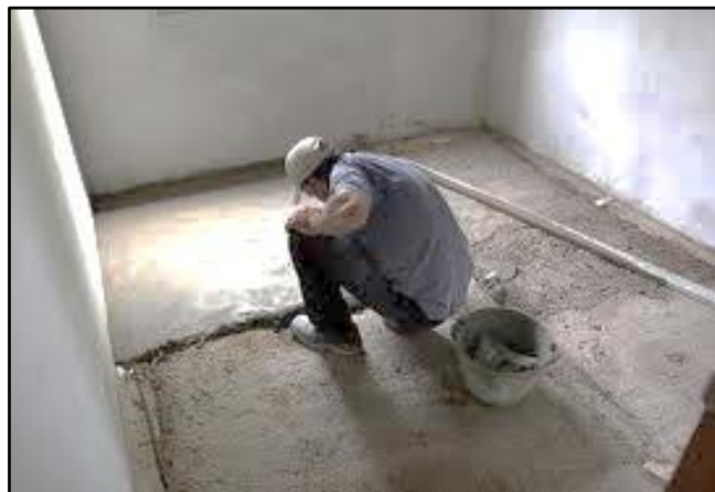
Figura 5.2. Rellenado de hormigón aligerado, sobre losa para dar pendiente
