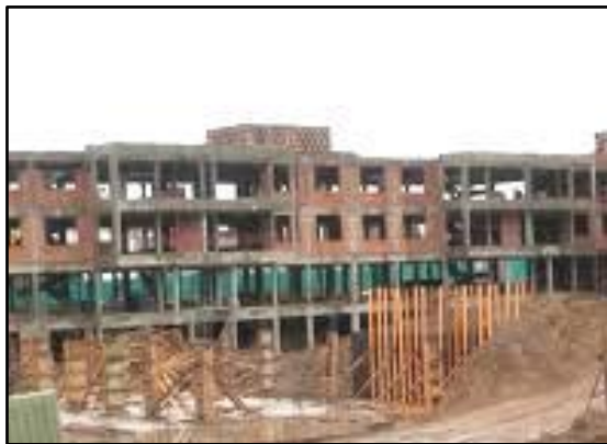
Figura 5.1. Construcción de una obra civil
