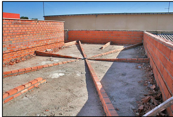
Figura 5.5. Fajas que dan la pendiente a la azotea
