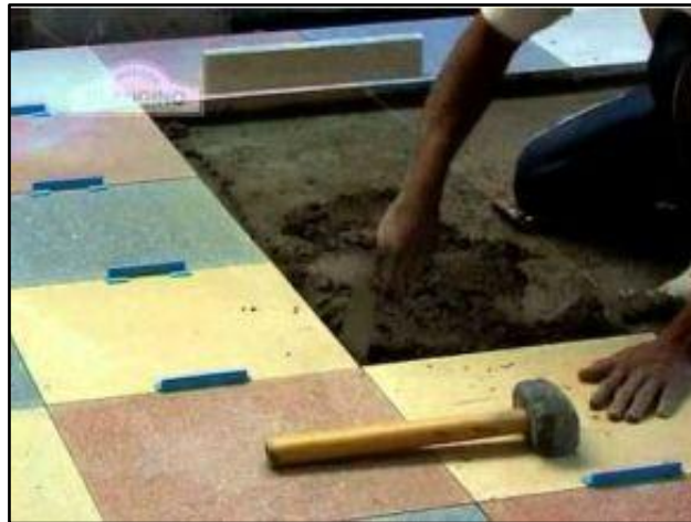
Figura 5.3. Mosaicos fijados con mortero
