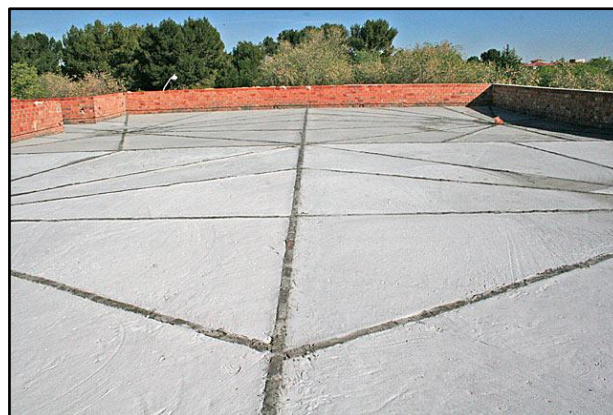
Figura 5.6. Azotea rellenada con hormigón aligerado
