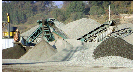
Figura 2.3. Planta de chancado de áridos
