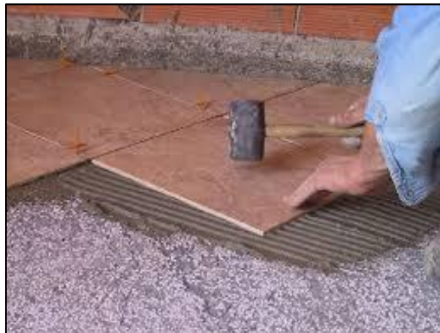
Figura 5.4. Piso cerámico fijado con pegamento especial
