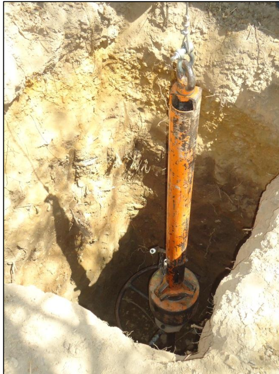
Figura 3: Fotografía tomada del equipo de "SPT" en el sitio de ensayo
