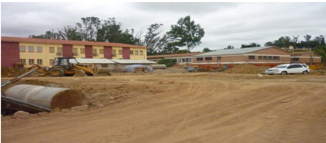
Figura 3.17.- Construcción Unidad Educativa Aniceto Arce
