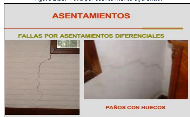
Figura 2.35.- Falla por asentamiento diferencial
