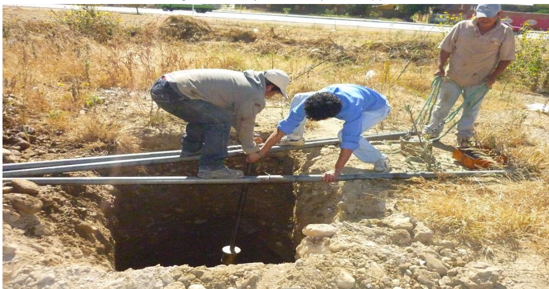
Figura 3.30.- Ensayo de SPT en el punto No 6 (3)
