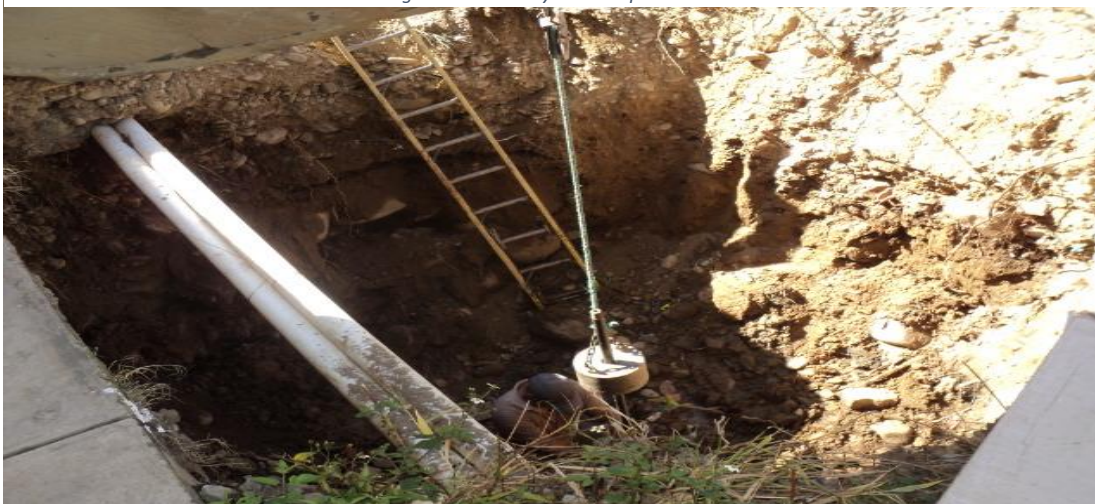
Figura 3.16.- Ensayo de SPT punto No 2
